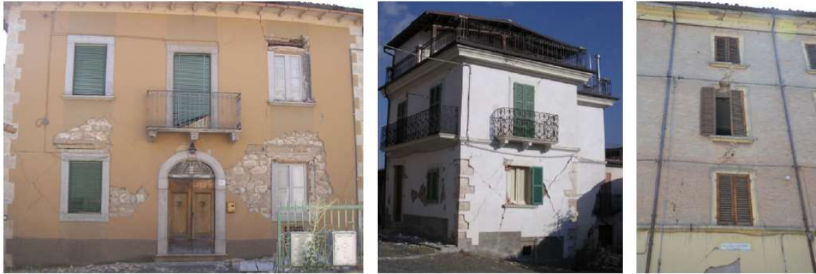
Figura 46: Osservazione dei danni post sisma
