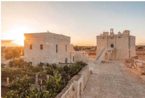
Figura 35 masseria Pettolecchia ristrutturata
