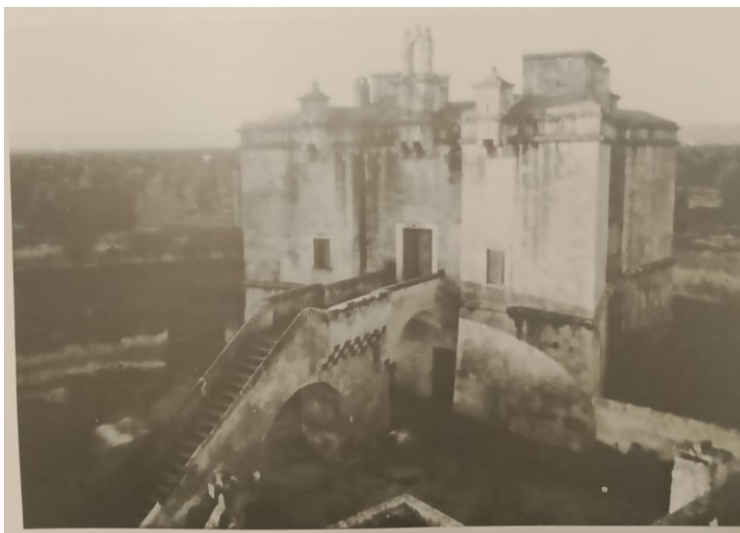
Figura 36 masseria Pettolecchia prima della ristrutturazione
