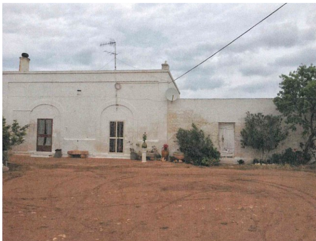
Figura 56 visione della casa del "massaro" con locali attigui
