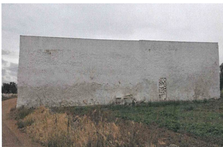
Figura 52 veduta esterna delle mura di recinzione
