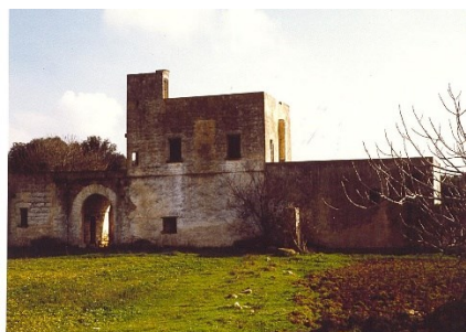
Figura 43 La masseria fortificata senza torre "Orfani"
