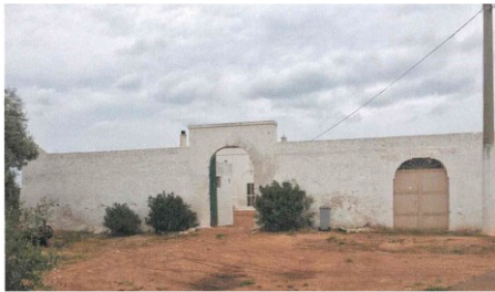
Figura 49 veduta esterna dell'ingresso della Masseria Martano
