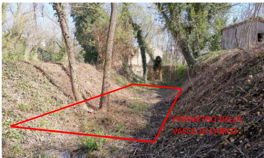
Figura 12: Vasca di carico del mulino attualmente presente
