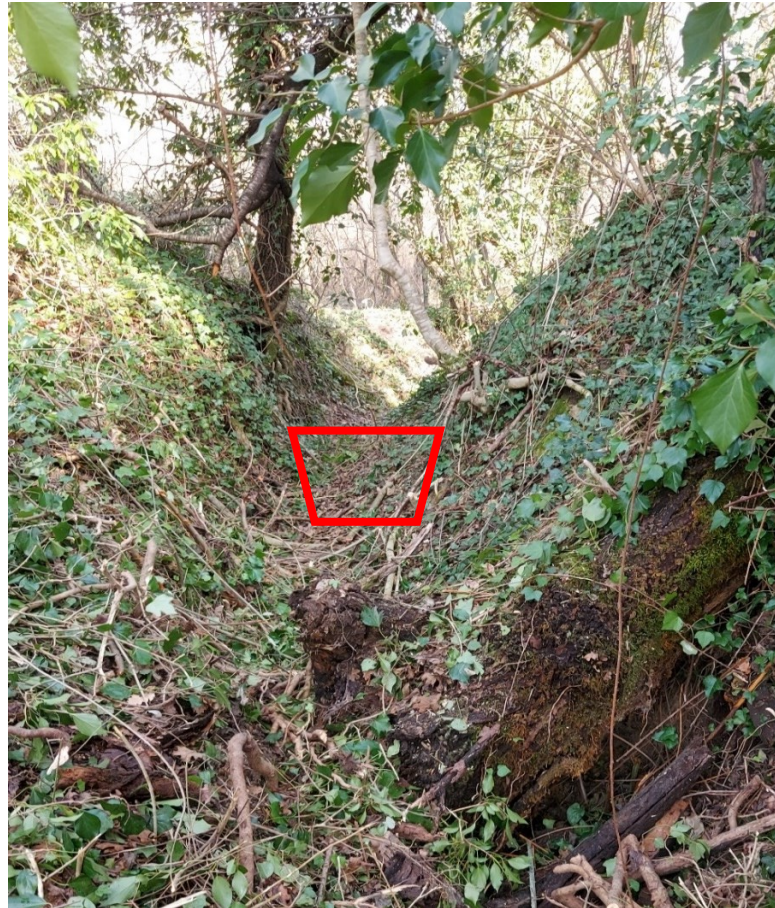
Figura 10: Riprofilatura del canale d'adduzione esistente
