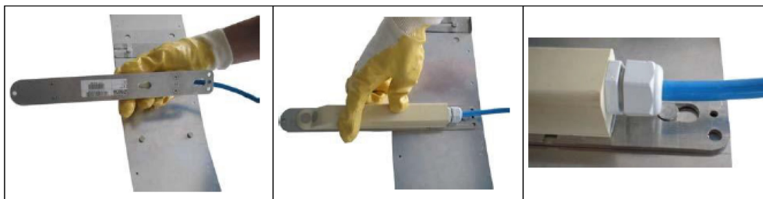
Figura 11 - Installazione del Kaptor Mini sulla piastra di base
