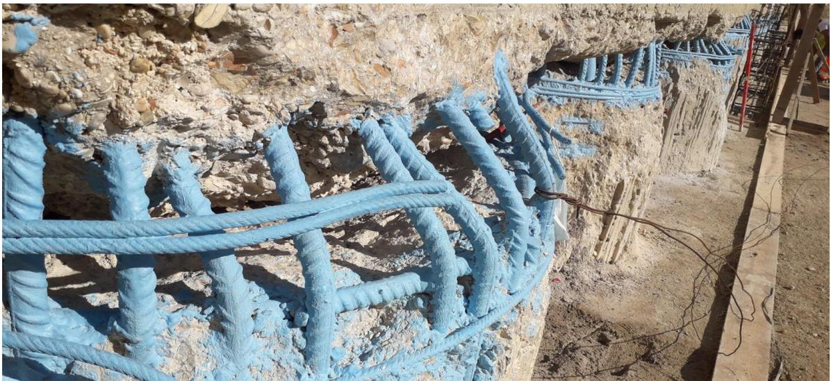
*Figura 4.15: Ciclo di passivazione dei ferri scoperti*
