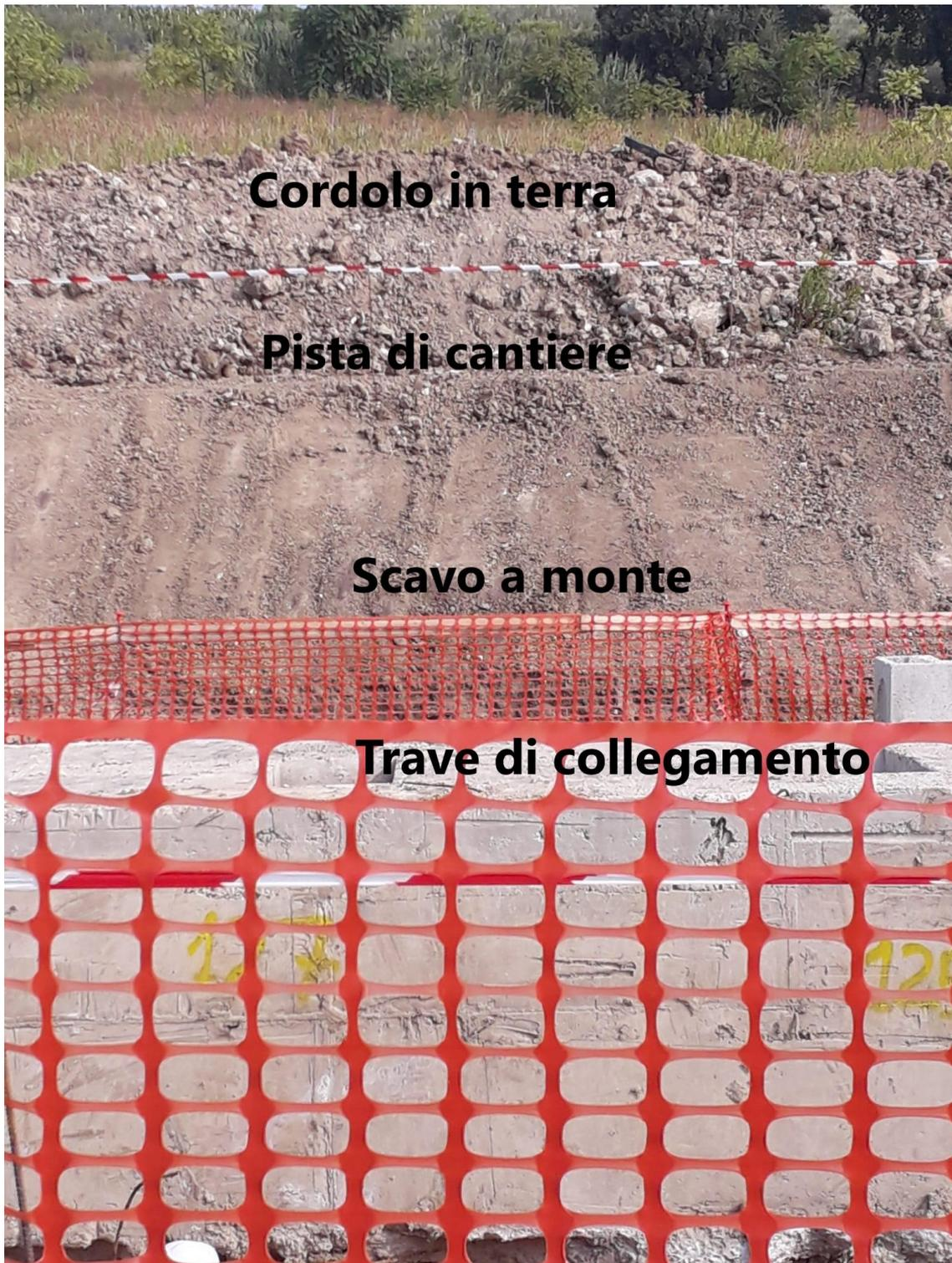
*Figura 4.3: Particolare dello scavo e del cordolo in terra realizzato sul versante*
