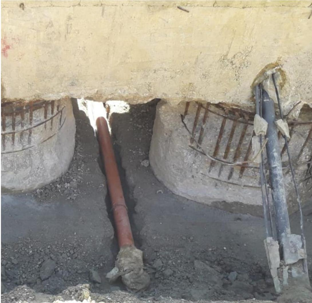
**Figura 4.4: Particolare del tubo di drenaggio**
