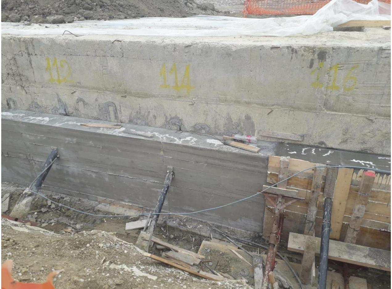
*Figura 4.20: Particolare della parete dopo la scasseratura*
