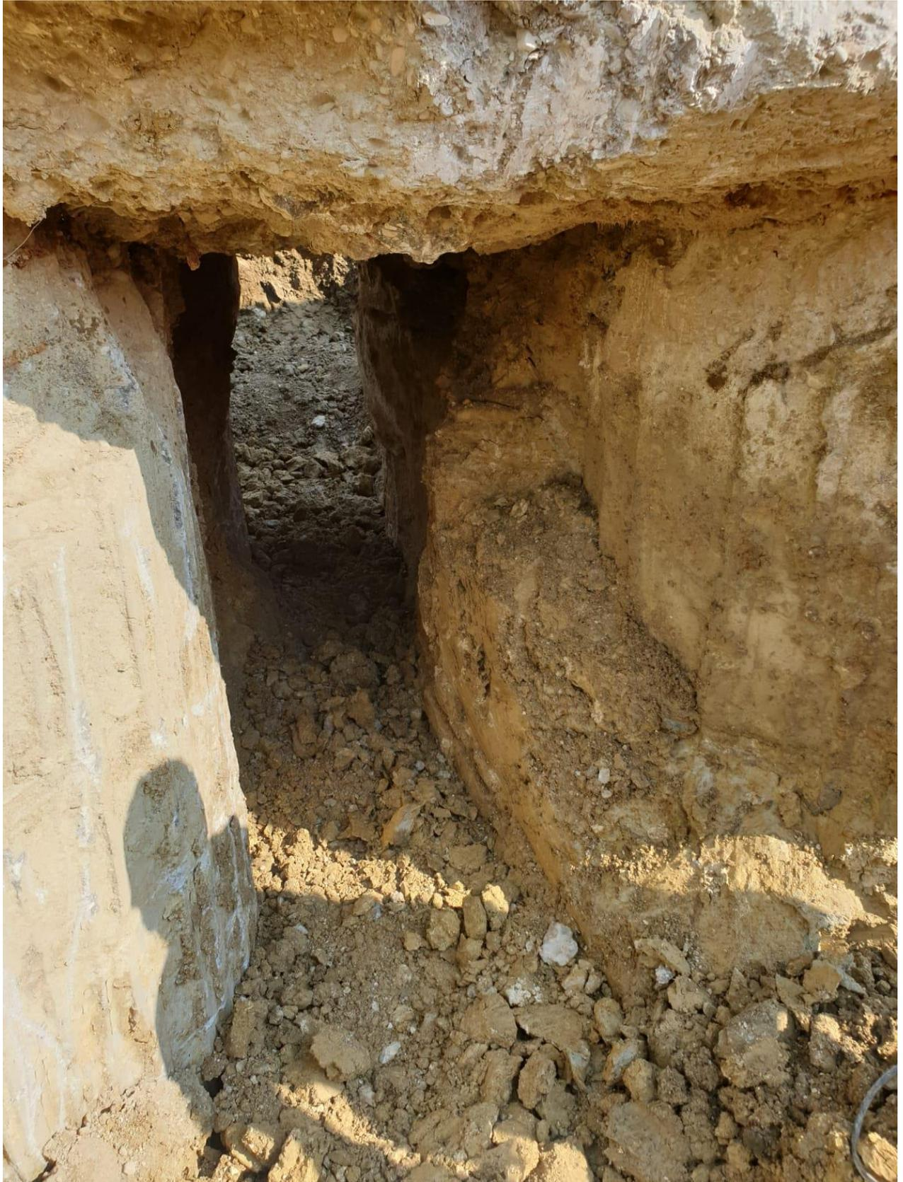
*Figura 4.8: Risultato della fase di scavo tra le coppie di pali*
