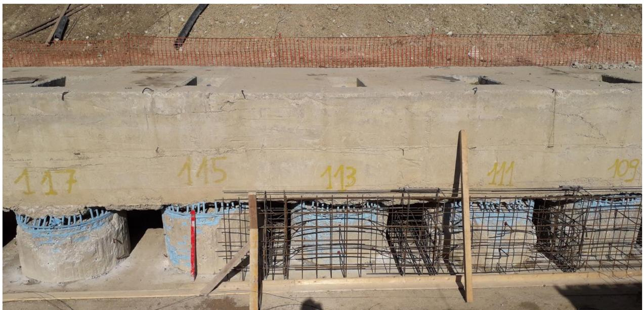
*Figura 4.18: Posa in opera della rete elettrosaldata*
