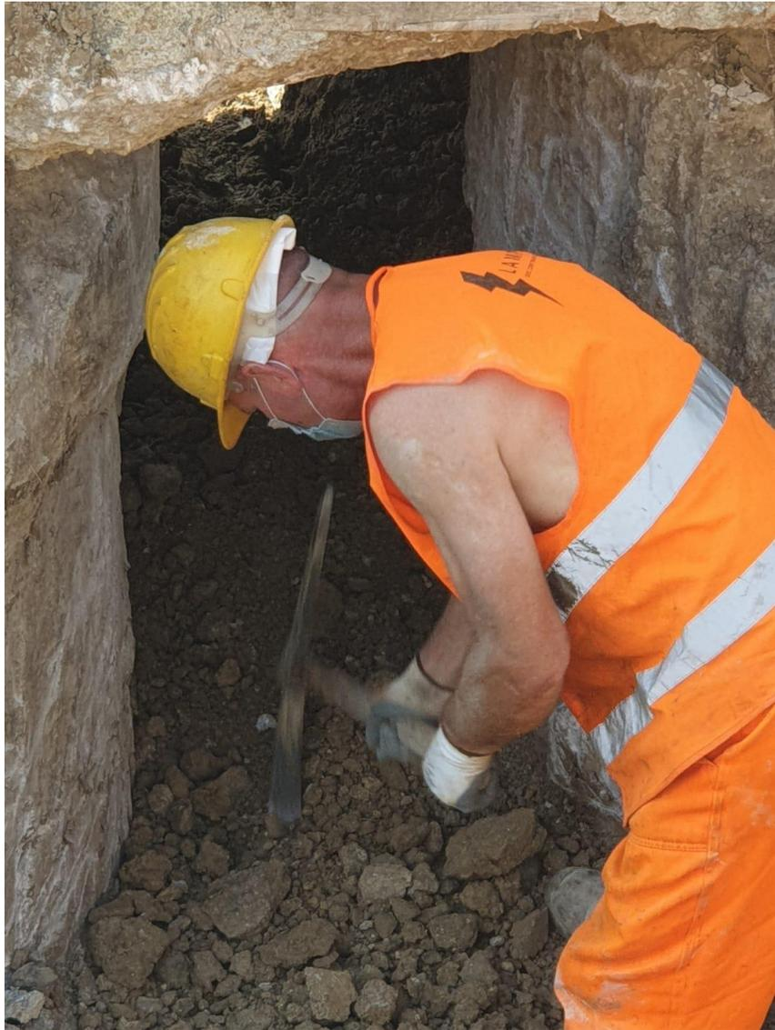
*Figura 4.7: Scavo con mezzi manuali*
