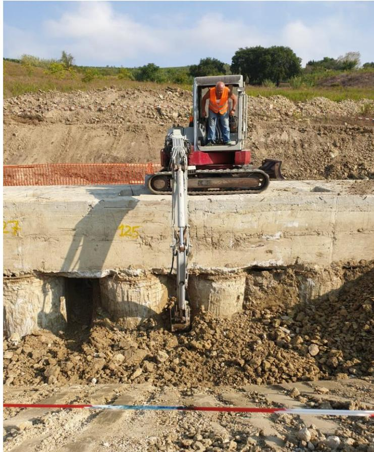
*Figura 4.6: Scavo a valle della paratia con mezzi meccanici*
