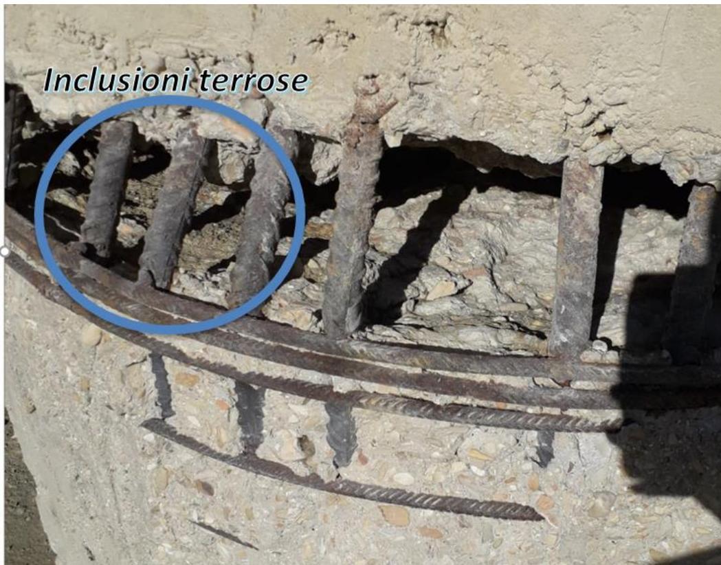
*Figura 3.2: Particolare della piegatura dei ferri d'evidenza delle inclusioni terrose*
