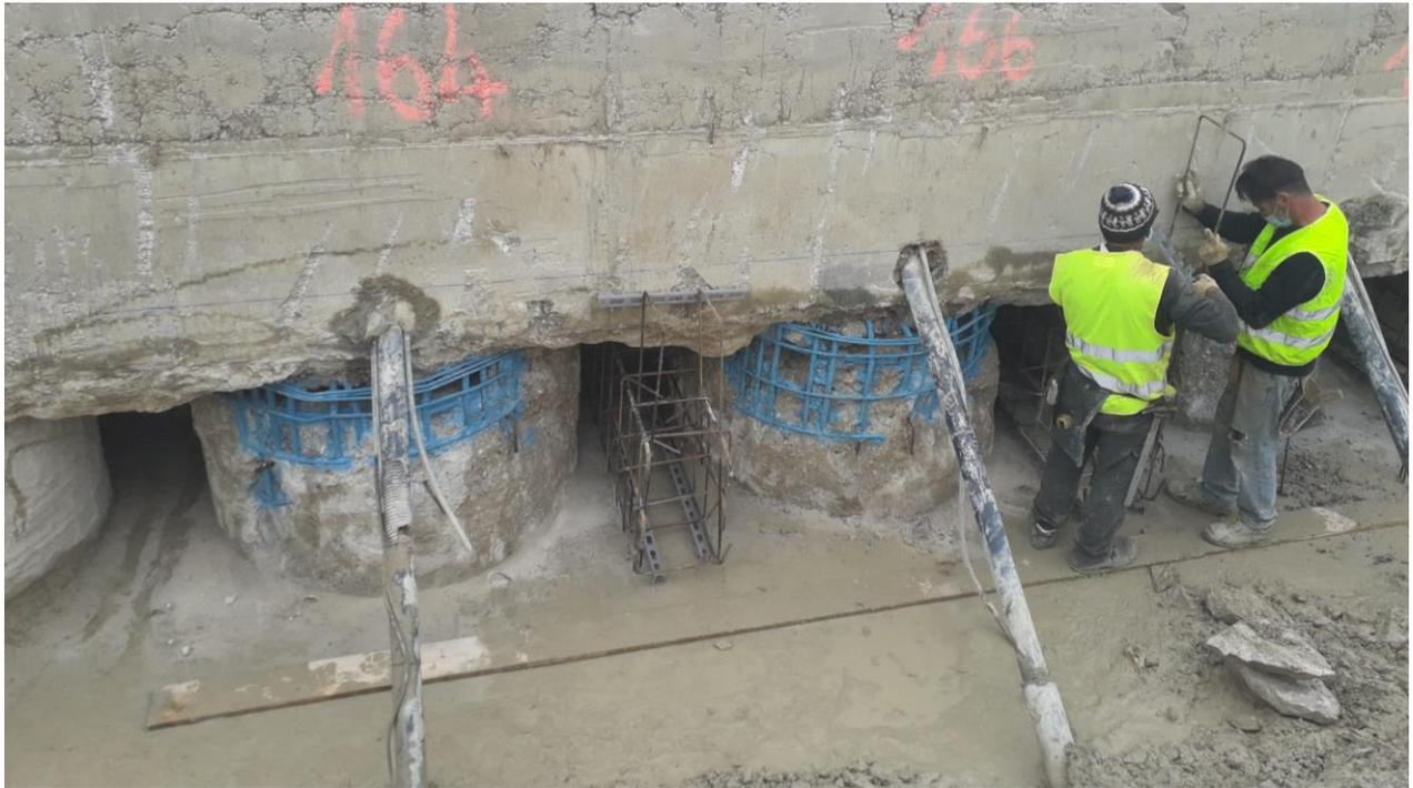
*Figura 4.17: Posa in opera dell'armatura aggiuntiva tra le coppie di pali*
