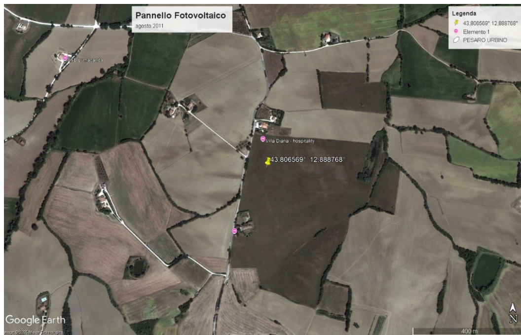
Figura 36 - Foto Google Earth Agosto 2011: Pannello non ancora in funzione
