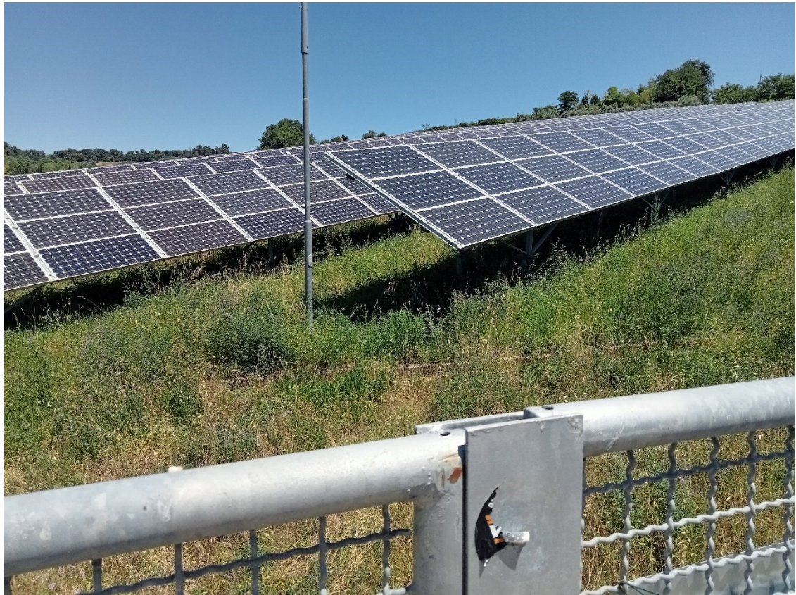
Figura 48 - Fotografia impianto fotovoltaico zona Fenile di Fano in “loco”
