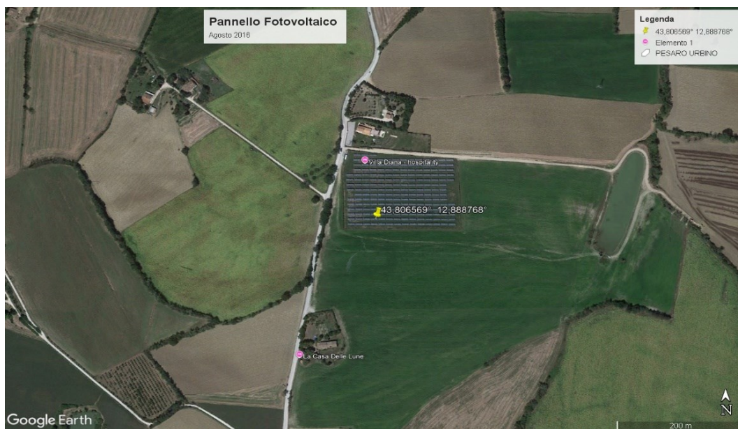
Figura 37 - Foto Google Earth Agosto 2016 (data consultabile): Pannello in funzione
