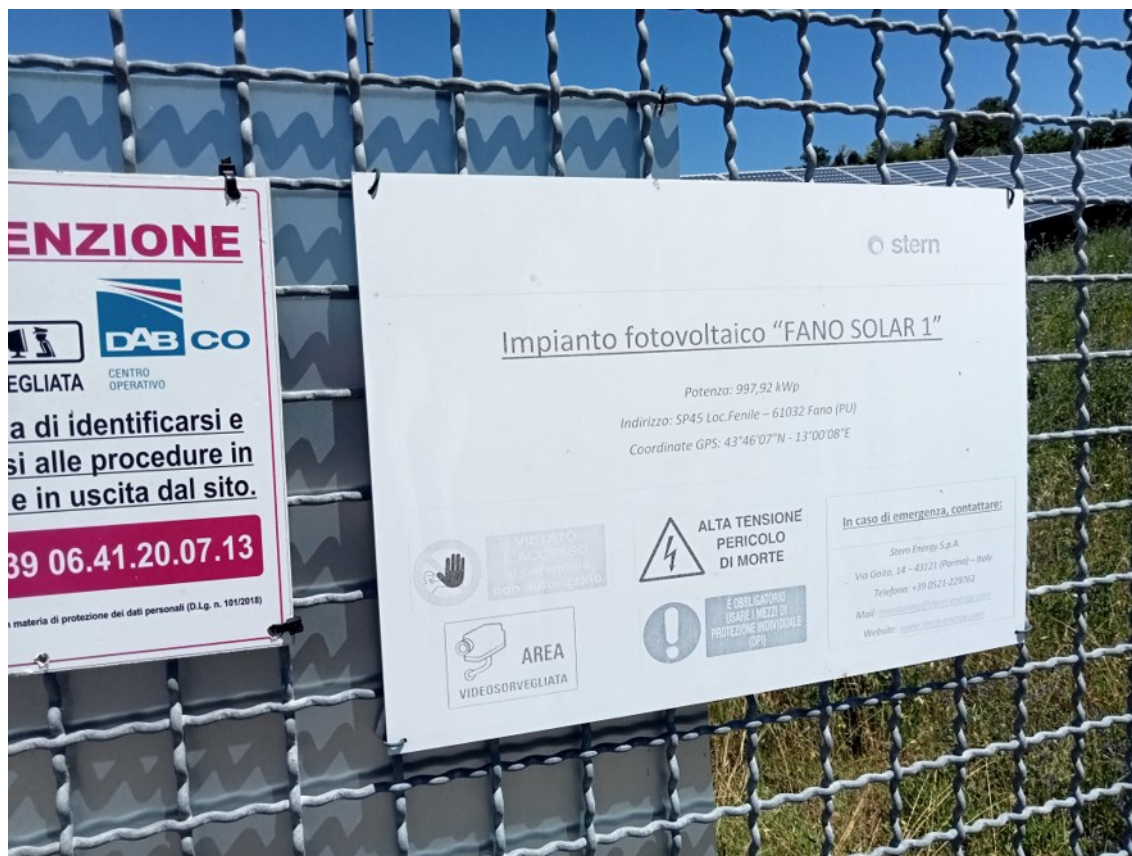
Figura 50 - Foto sui dati dell'impianto fotovoltaico
