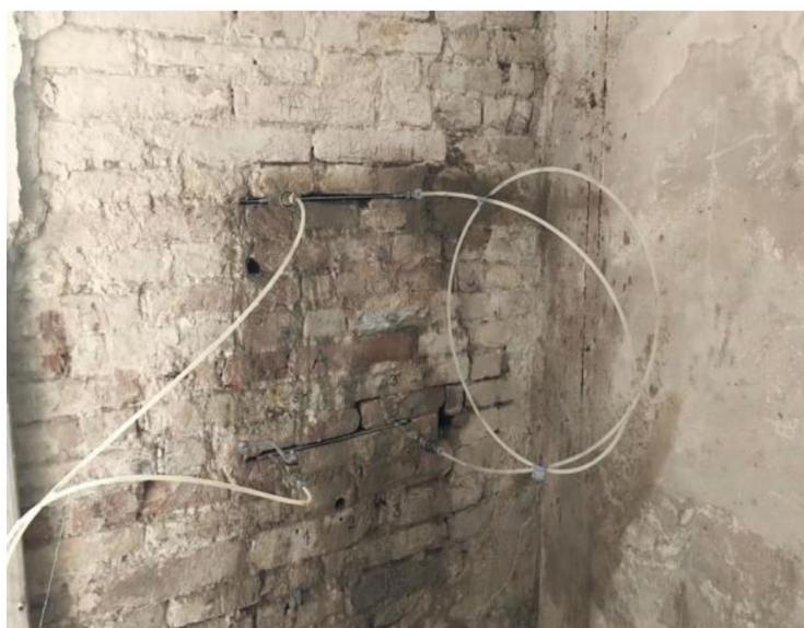
Fig. 5.4.1.2.VII –posizionamento del martinetto piatto singolo – punto di prova 2
