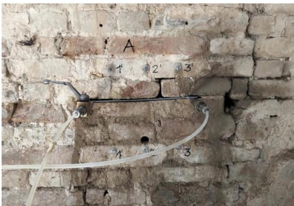
Fig. 5.4.1.2.III – posizionamento del martinetto piatto nella muratura
