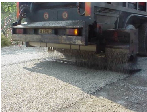
Figura 3.5 – Depolverizzazione
