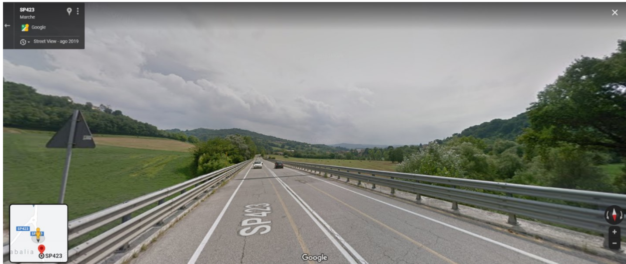
Foto 8.2: Vista verso monte, in prossimità della spalla (Google Maps, street view).
