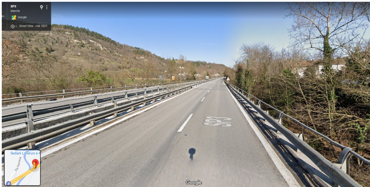
Foto 7.2: Vista verso valle, in prossimità della spalla (Google Maps, street view).
