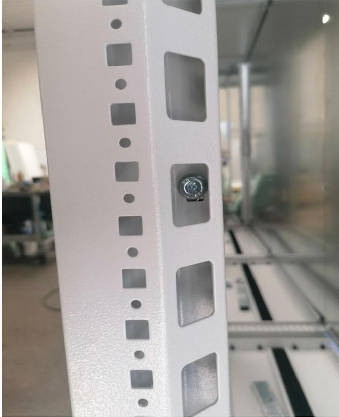
**Figura 3: Fotografia bullonatura di fissaggio tra gli armadi al fine di formare la batteria, mediante n.8 pezzi di vite M8x20 passo 1,25 classe 8.8 in acciaio galvanizzato.**
