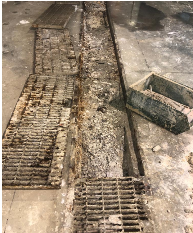
Figura 20: Canaline prima della pulizia
