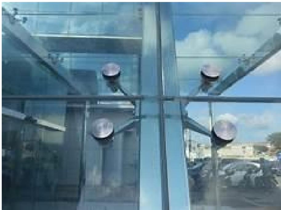
*Figura 4. Dispositivo di sostegno meccanico (a ragno)*
