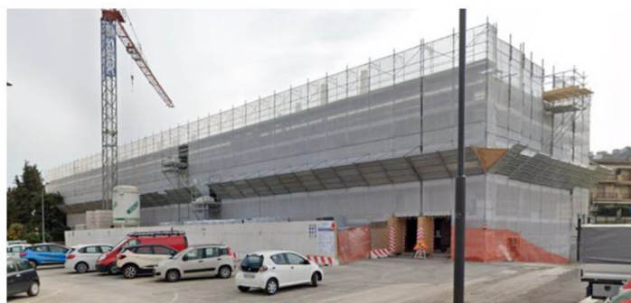
Figura 2-34: Vista esterna Condominio Mantova
