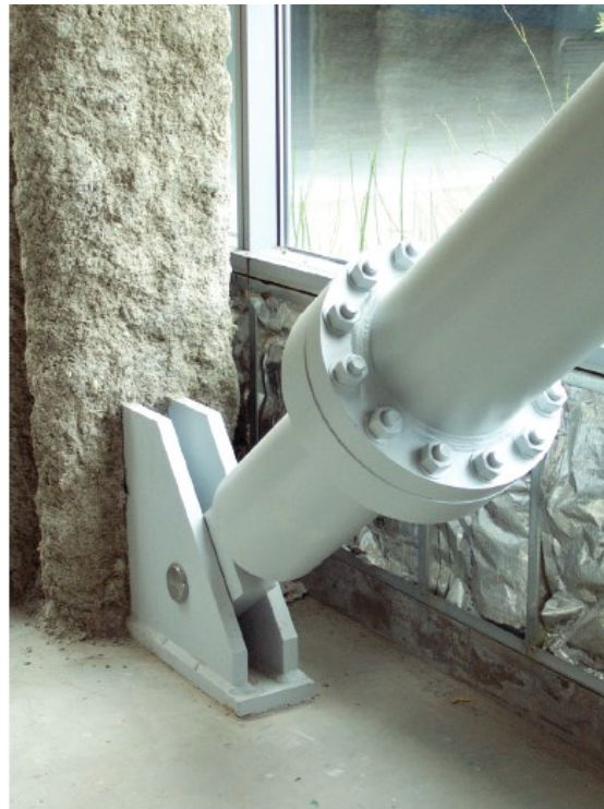
Figura 5.27 Esempi applicativi di dispositivi viscosi come quelli previsti nella presente tesi
