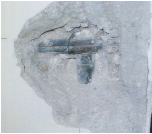
Figura 2.24 Da sinistra: Pilastro 27 piano terra e Pilastro 24 piano terzo - Scasso eseguito per verificare il diametro e lo stato di conservazione di un ferro d'armatura e di una staffa
