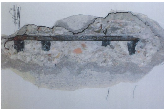
Figura 2.25 Da sinistra: Trave 15-27 piano primo e Trave 21-22 secondo - Scasso eseguito per verificare il diametro e lo stato di conservazione dei ferri d'armatura nella mezzeria della trave
