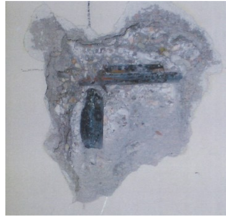
Figura 2.24 Da sinistra: Pilastro 27 piano terra e Pilastro 24 piano terzo - Scasso eseguito per verificare il diametro e lo stato di conservazione di un ferro d'armatura e di una staffa
