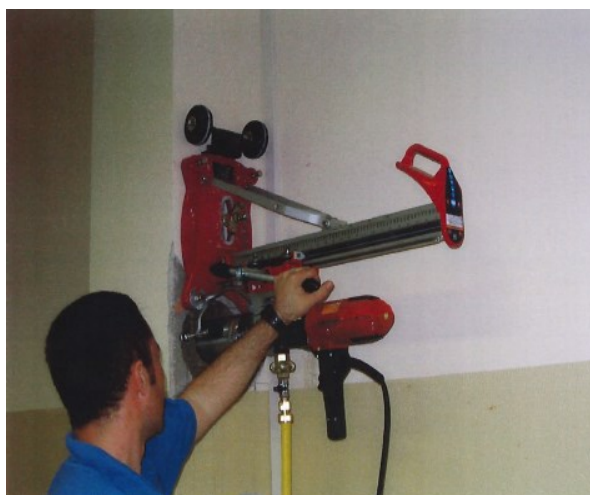
Figura 2.31 Da sinistra: Campioni di calcestruzzo prelevati in corrispondenza dei pilastri dell'edificio e prelievo di un campione di calcestruzzo da un pilastro mediante carotaggio continuo ad acqua.
