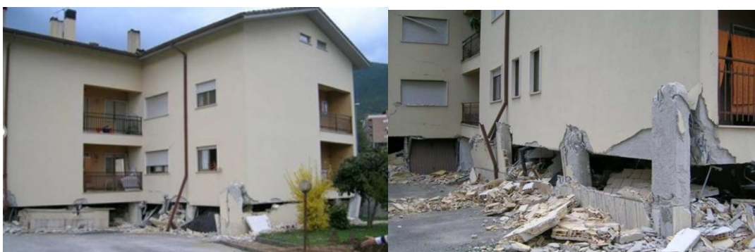
Figura 1.5 Esempio di meccanismo di piano soffice
