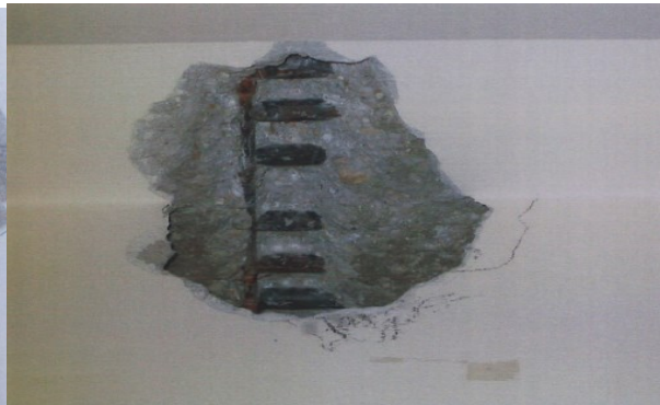
Figura 2.25 Da sinistra: Trave 15-27 piano primo e Trave 21-22 secondo - Scasso eseguito per verificare il diametro e lo stato di conservazione dei ferri d'armatura nella mezzeria della trave
