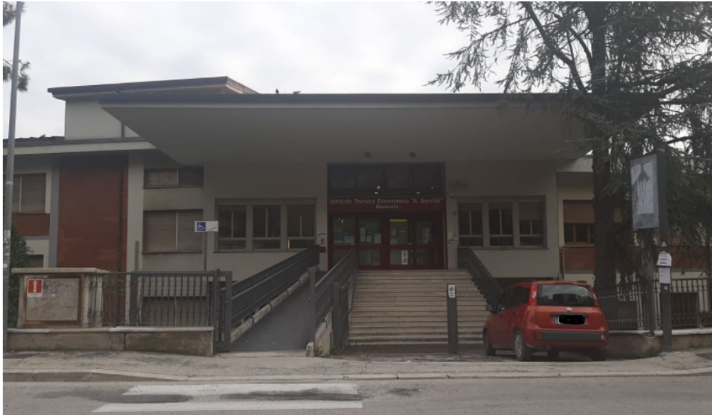
Figura 2.3 Vista Ingresso del blocco A2 dell'Istituto Tecnico Commerciale A.Gentili
