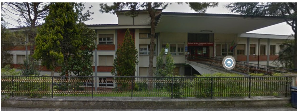
Figura 2. 2 Vista dal lato ingresso del blocco A2 dell'Istituto Tecnico Commerciale A.Gentili
