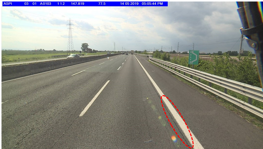
Figura 3.13 b: giunto di stesa della pavimentazione (stesa della corsia di emergenza)
