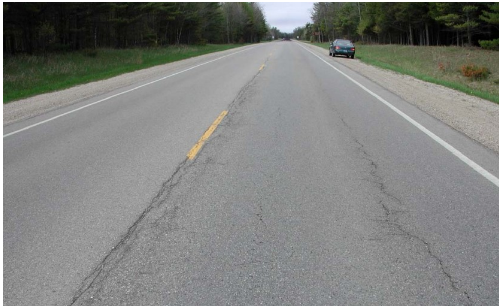
Figura 1.4 : esempio di pavimentazione affetta da top-down cracking
