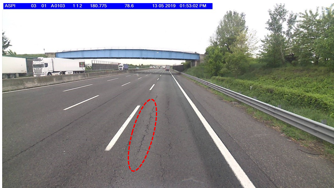
Figura 3.12 a: fessura da top-down (sono presenti anche delle fessure secondarie parallele denominate in letteratura "sister cracks")
