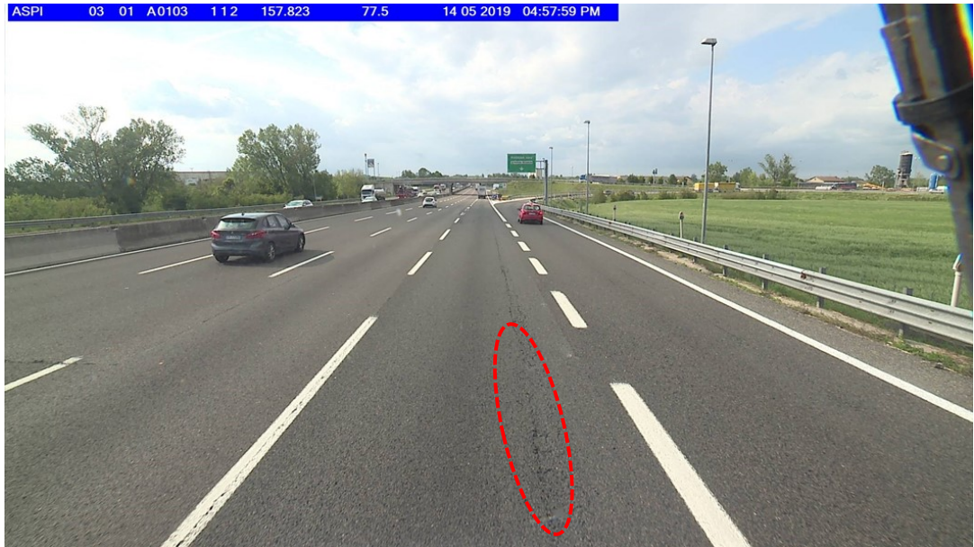
Figura 3.12 b: fessura da top-down
