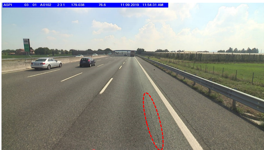
Figura 3.14 : fessura dovuta a foratura dello pneumatico (incisione)
