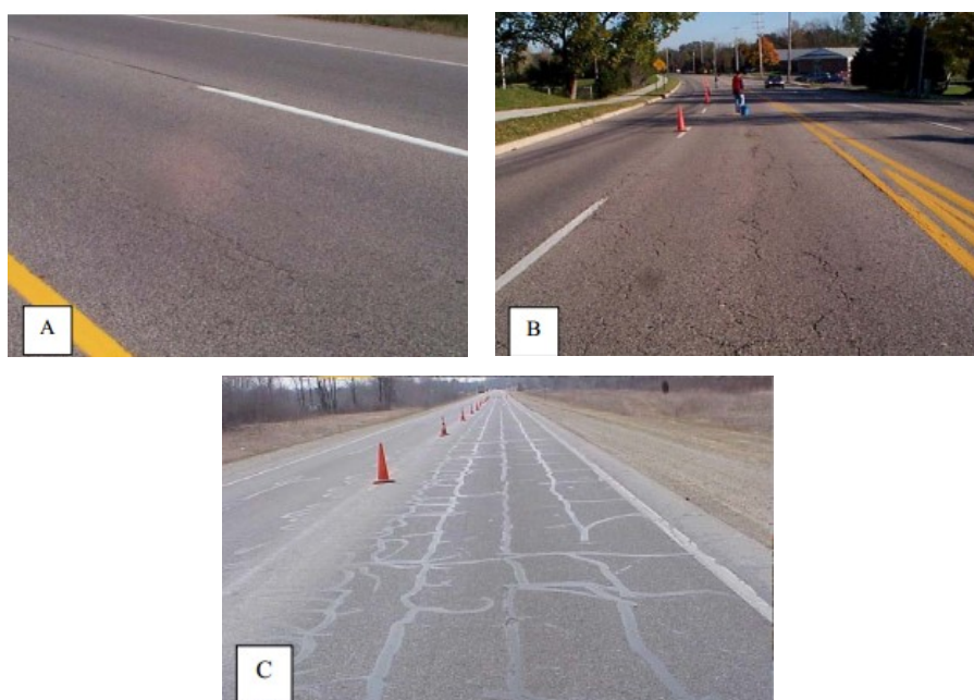
Figura 1.6: sviluppo del fenomeno del top-down cracking in tre fasi: fase 1 (a); fase 2 (b); fase 3 (c)
