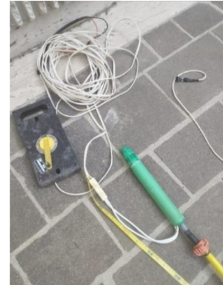
Figura 39, Pompa per immissione del tracciante utilizzata
