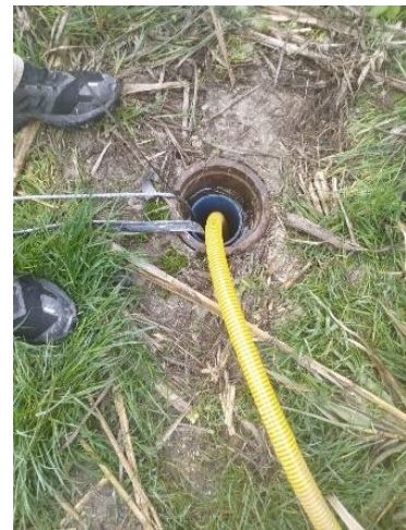
Figura 32, Vista del piezometro esterno Betelico (a valle)
