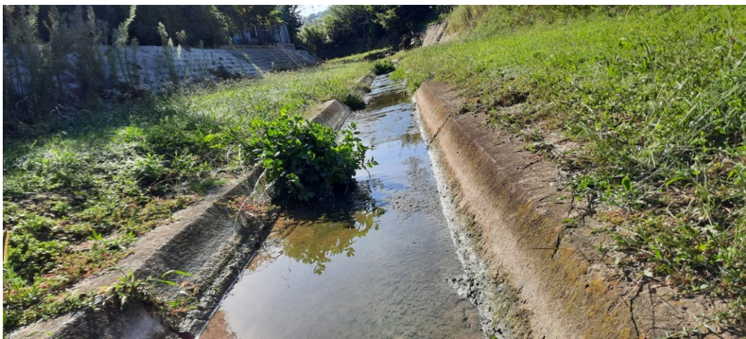
Fig. 4.29 Sezione di alveo trapezoidale (Vallemiano)
