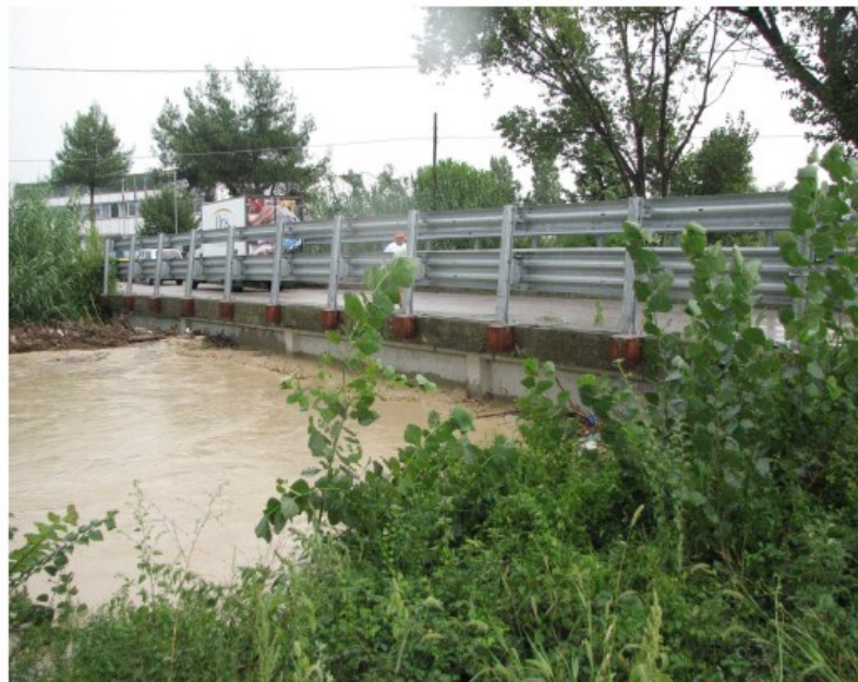
Fig. 3.4 Livello a valle del ponte del Fiume Aspio
