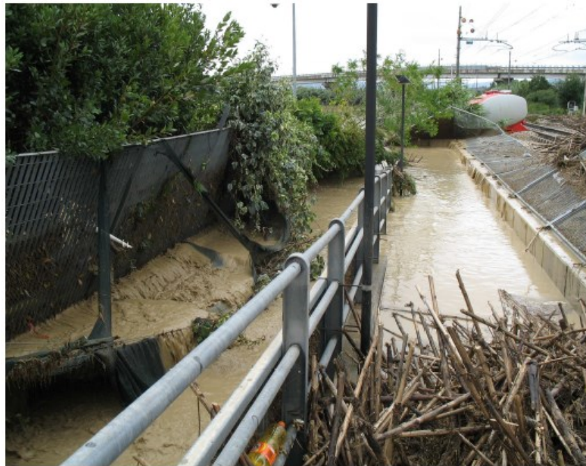
Fig. 3.7 Effetti dell'allagamento sulla rete ferroviaria
