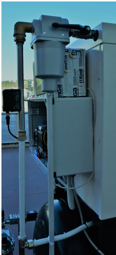
<- Figura 5.11: Posizione sensori di portata e volume aria compressa a monte del serbatoio
