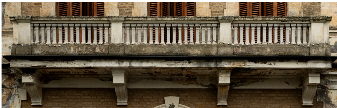
Figura 45. RestauRO balcone (Elab. Grafico Arch. Giovanni Monelli, 1996 - Archivio Ce.Fo.Av.En.)
