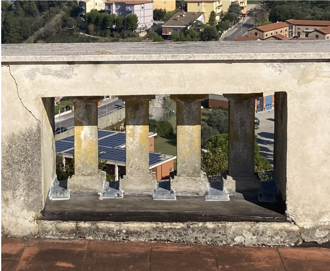
Figura 43. Impermeabilizzazione copertura, particolari balastrini (Foto Fabio Mirra, 2022)
