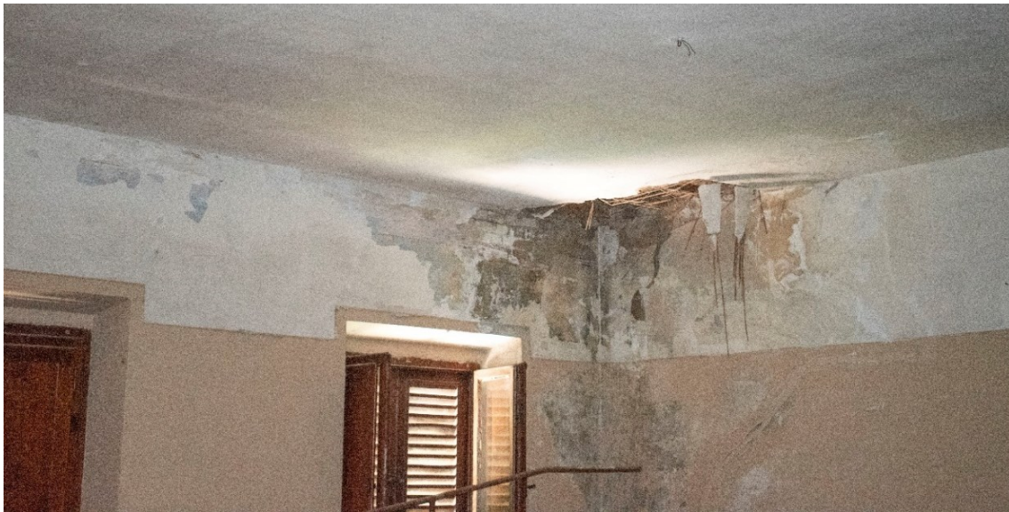
Figura 76. Controsoffitto in camorcanna danneggiato da infiltrazioni. (Foto Fabio Mirra, 2021)
