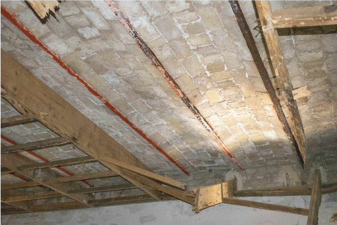
Figura 48. Rimozione controsoffitto vano 51 (Foto Fabio Mirra, 2021)
