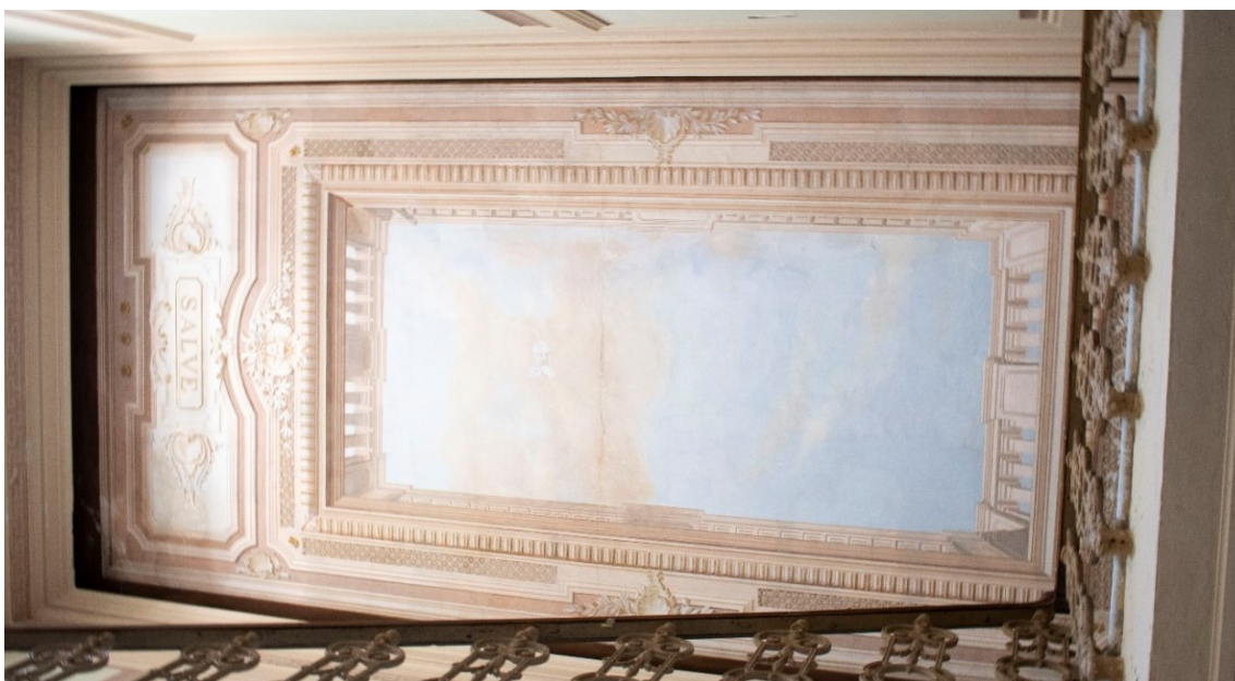
Figura 77. Particolare del soffitto vano scalone principale. (Foto di Fabio Mirra, 2021)
