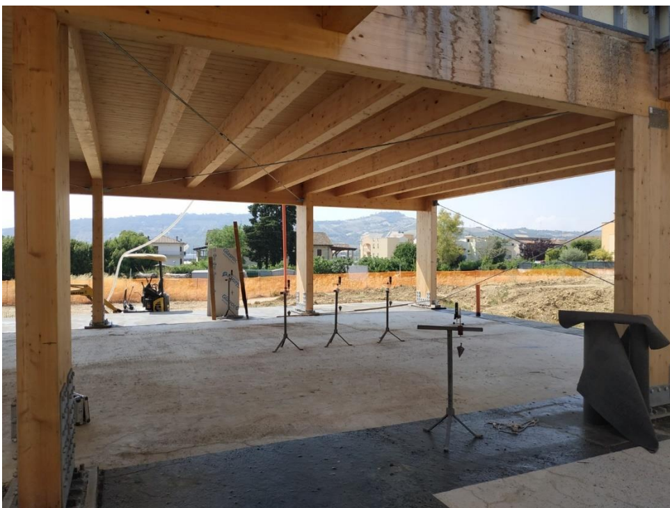
Figura 5.7 : Prova di carico su solaio realizzato in legno
