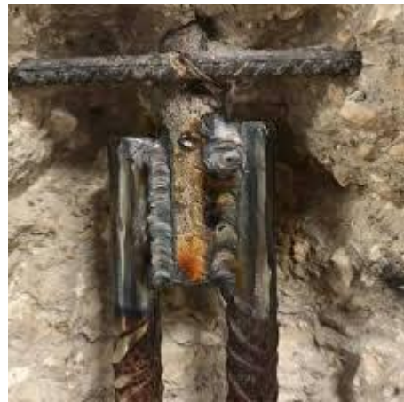
Figura 1.19 : Prelievo di barra da un pilastro in calcestruzzo armato Figura 1.20 : Tratto di barra prelevato sostituito per mezzo saldatura
