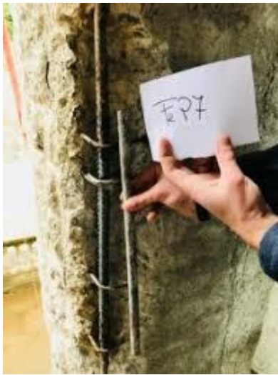
Figura 1.19 : Prelievo di barra da un pilastro in calcestruzzo armato Figura 1.20 : Tratto di barra prelevato sostituito per mezzo saldatura
