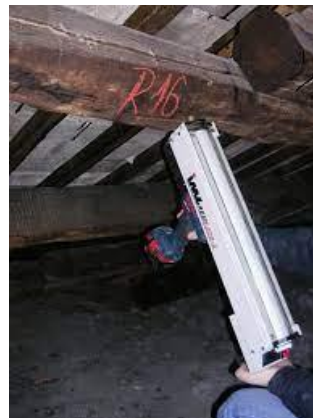
Figura 1.23 : Strain Gauge nelle prove di rilievo tensionale Figura 1.24 : Prove resistografiche tramite trapano strumentato
