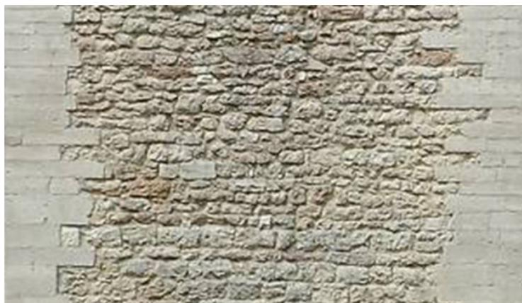
Figura 21: Rivestimento esterno: blocchi in pezzatura mista nella parte centrale e lastre uniformi di pietra liscia sugli spigoli
