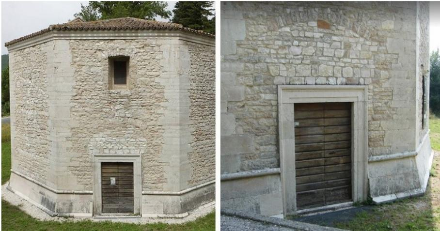
*Figura 22: Rivestimento esterno: blocchi in pezzatura mista nella parte centrale e lastre uniformi di pietra liscia sugli spigoli*
