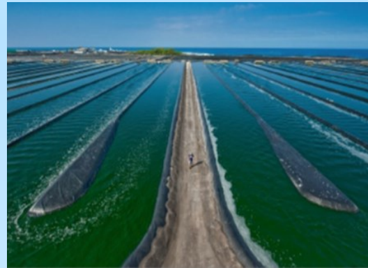
Le canalette sono uno stile di laghetto adatto alla crescita micro-algale che ottimizza l' utilizzo della luce in una determinata area unitaria.
