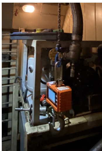
Figura 38 Metodo di pesatura delle bombole antincendio
