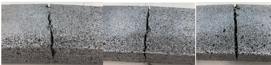
Figura 46: Partendo da sinistra troviamo le immagini della fessura principale nei provini UHPFRC_50_D, E, F
