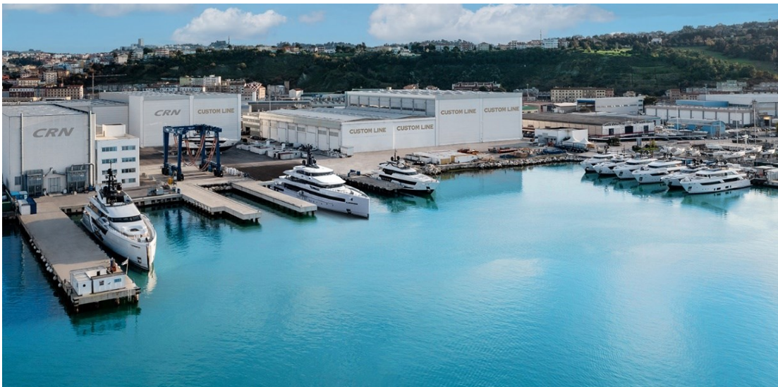
Figura 1: cantiere CRN Ancona
