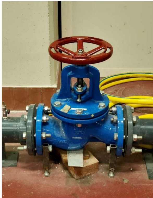
Figura 16. Valvola a flusso avviato.
