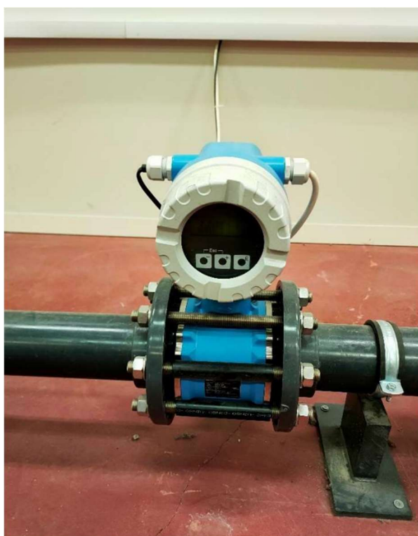
Figura 20 a. Misuratore di portata di monte (Promag 10D80) Figura 20 b. Misuratore di portata di valle (Promag 400)
