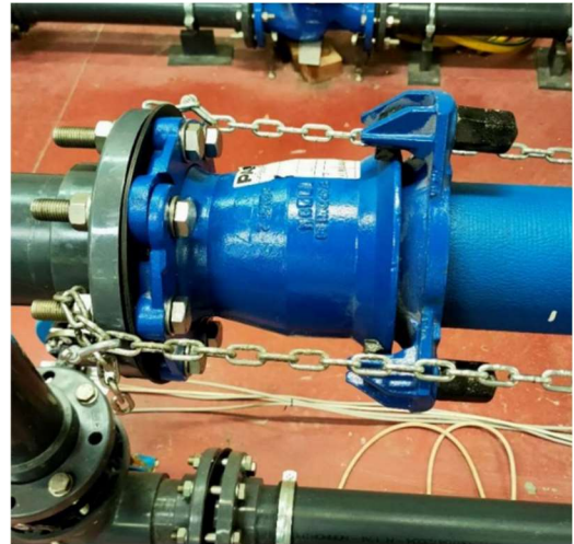
Figura 12 b. Collegamento con imbocco flangiato a valle
