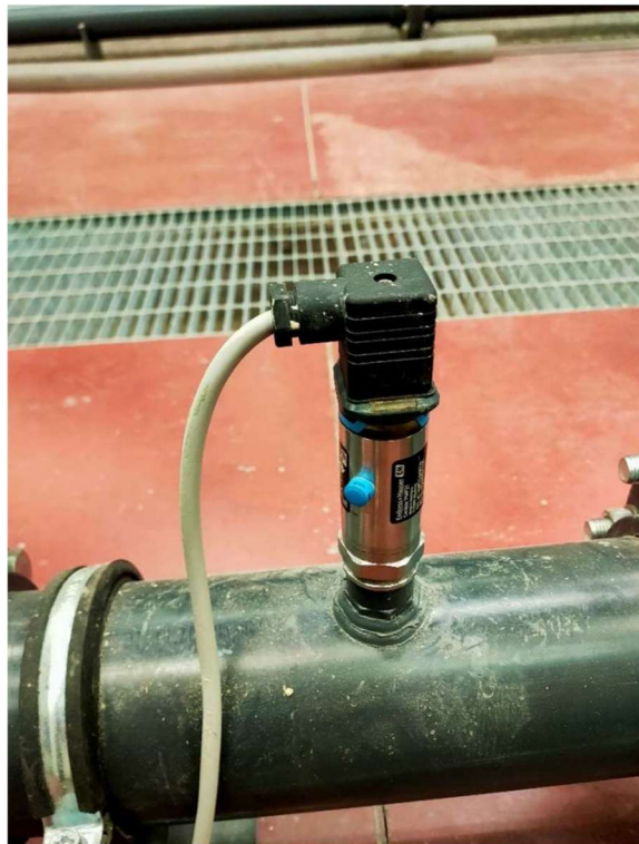
Figura 19. Manometro a membrana.
