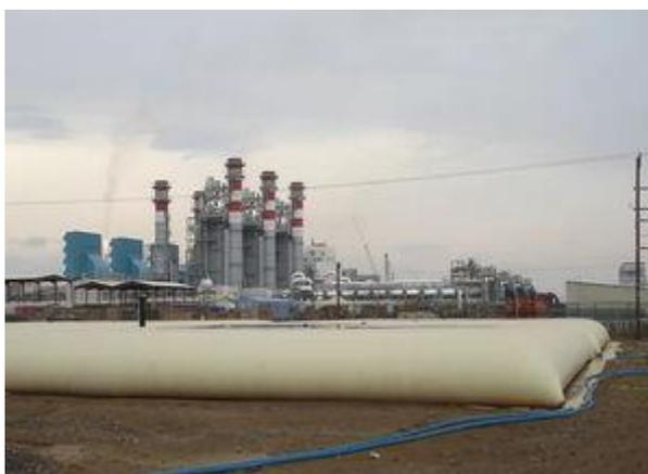
Figura 15. Esempio di serbatoi per lo stoccaggio dei liquidi di perforazione (Bindi, 2018)
