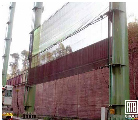
Figura 17. *Esempio di perimetrazione dell'area di lavoro in presenza di fluidi di perforazione* ([www.soeg.it](http://www.soeg.it), 2017)
