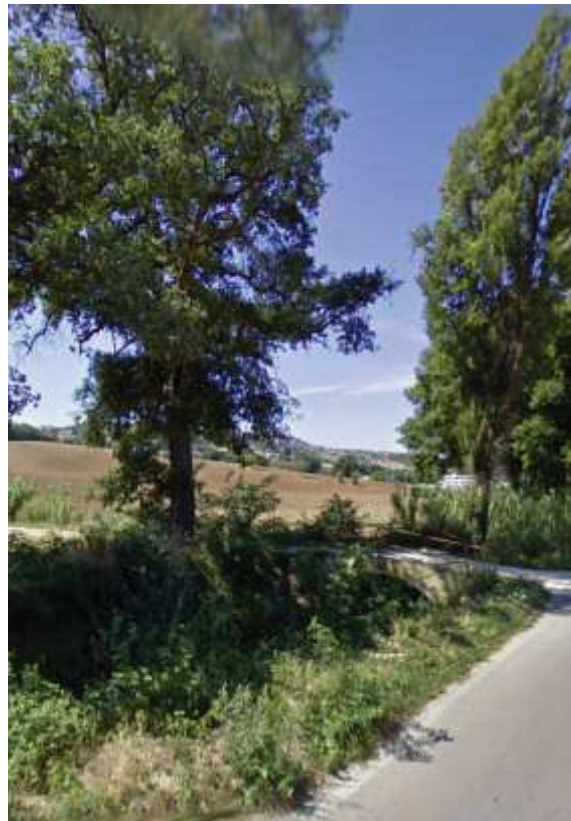
Fig. 4. 90 – foto del ponte che, da via Molinaccio, permette l’attraversamento del fosso San Valentino in corrispondenza della sezione n. 9
