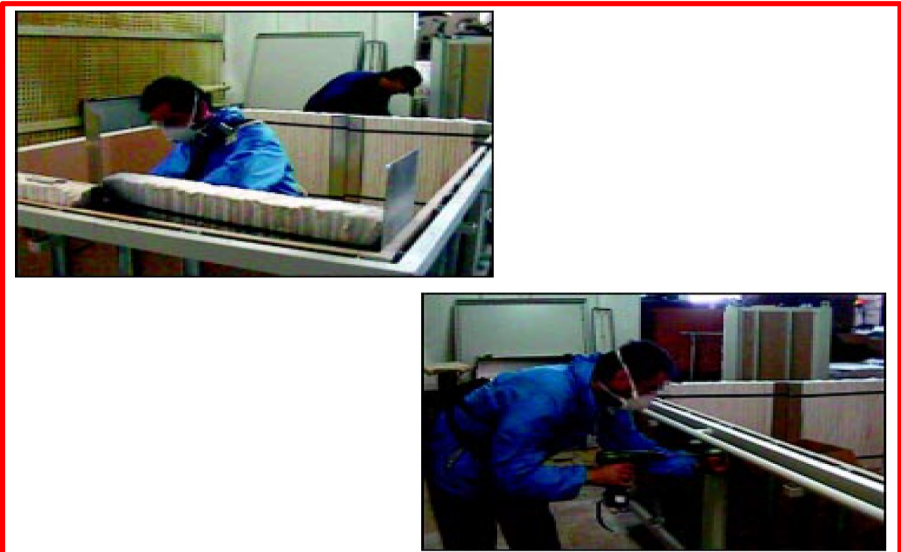
7: Lavori di coibentazione con pannelli in FCR di componenti di un forno
