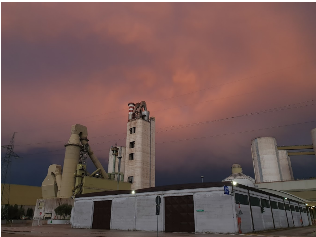
Figura 22 – Impianto produttivo Colacem Sesto Campano
