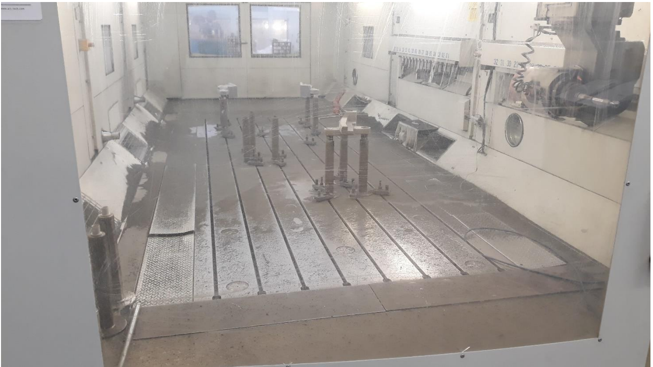
(fig. 5.4 interno di una delle fresatrici presenti in ArsTech)
