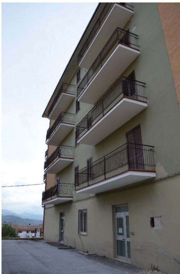
Figura 5.24: Vista dei balconi
