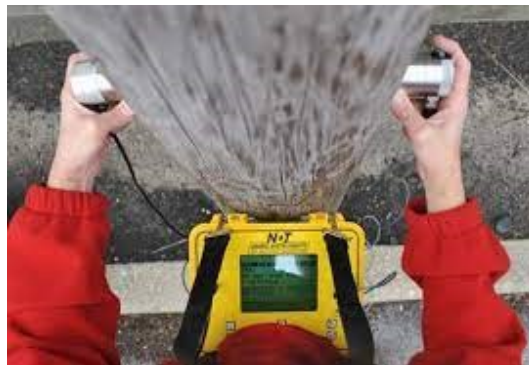
Figura 5.30: Esecuzione di una prova ultrasonica
