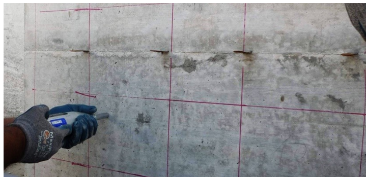
Figura 5.31: Esecuzione battuta sclerometrica
