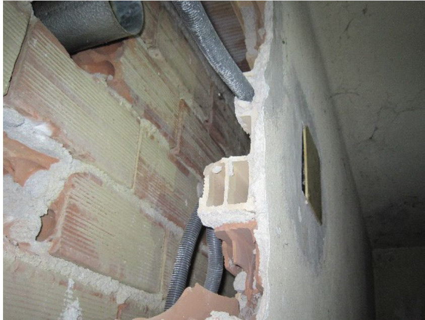
Figura 5.20: Vista del paramento interno del muro contro terra
