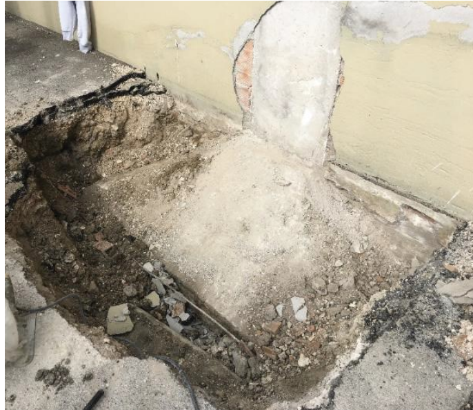
Figura 5.23: Particolare del plinto di fondazione
