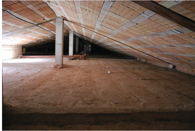
Figura 5.25: Struttura della copertura a padiglione
