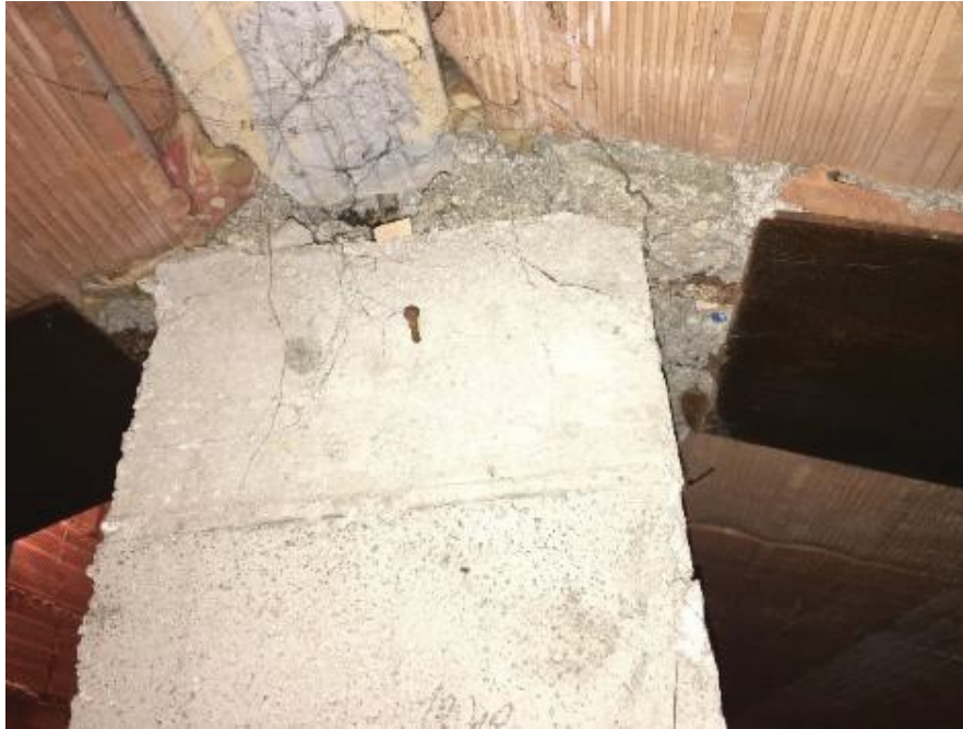
Figura 5.15: Travi REP a sostegno della copertura
