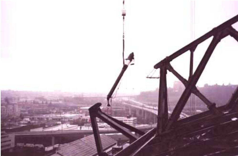
Figura 3.18: Dissipatori fluidodinamici posizionati al posto di reticolari
