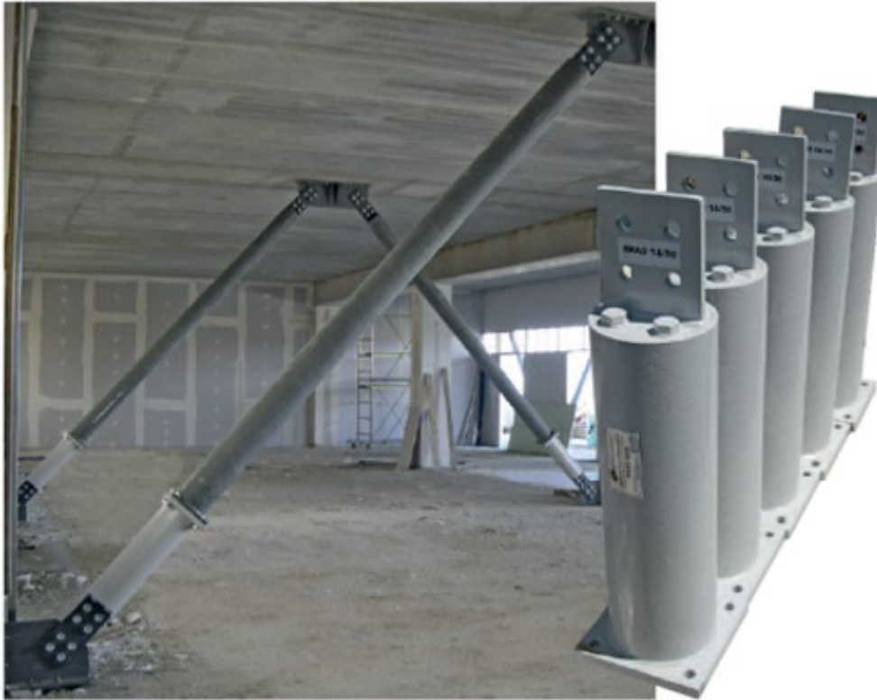
Figura 2.10: Particolare di un controvento posto in opera. In bianco la parte dissipativa (BRAD).
