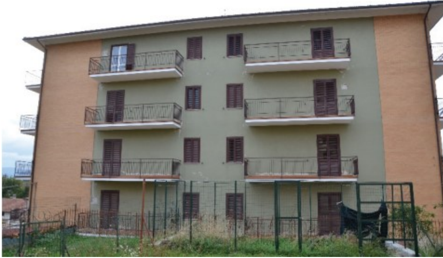
Figura 5.26: Vista tamponature esterne
