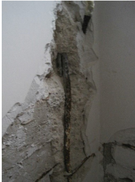
Figura 5.18: Armatura liscia dei pilastri
