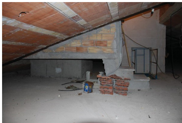
Figura 5.22: Extra-corsa del nucleo ascensore
