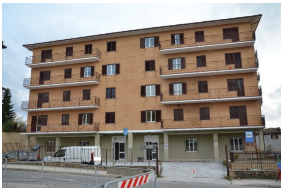
Figura 5.2: Prospetto Nord edificio Fazzini
