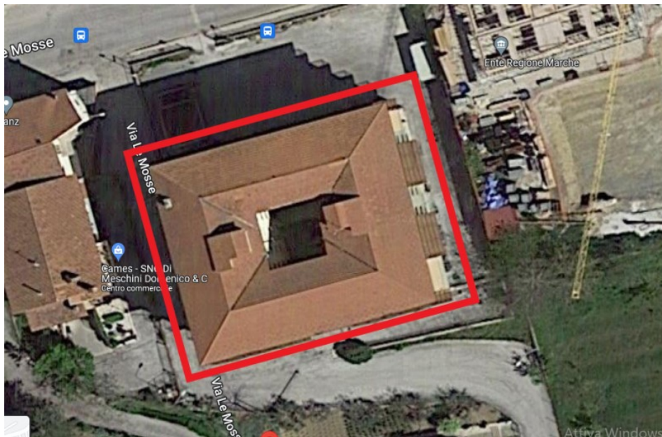
Figura 5.1: Vista aerea edificio Fazzini
