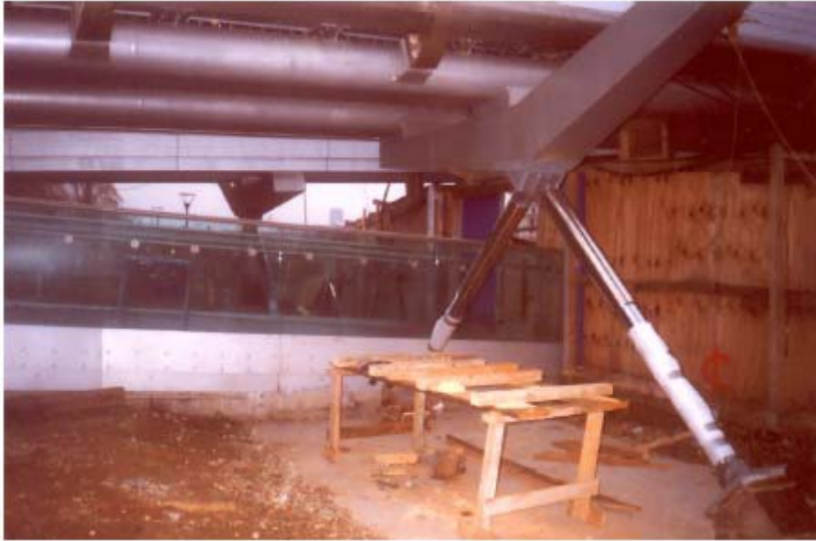
Figura 3.19: Dissipatori in posizione verticale all'attacco della passerella.
