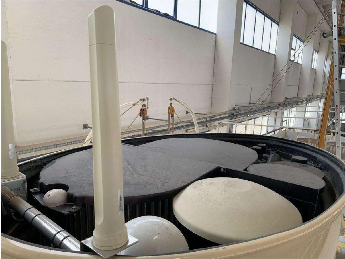
Figura 14: antenne all'interno del fumaiolo
