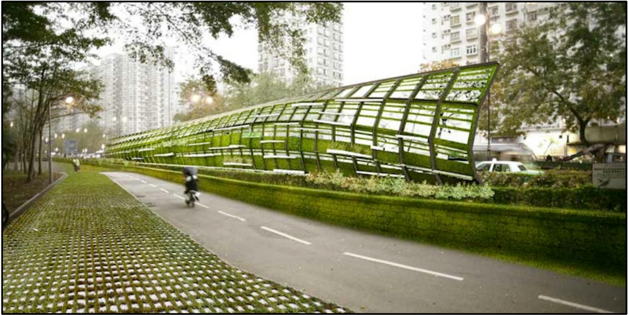
Figura 24. Esempio di alberi e arbusti disposti al fine di realizzare una barriera antirumore (Teknoring, giugno 2024).
