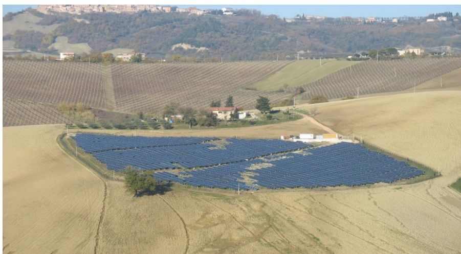
Immagine 3.2 Immagine di un impianto fotovoltaico danneggiato da uno smottamento della collina
