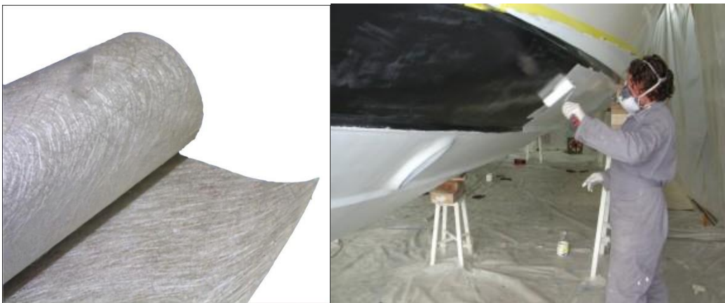
Fig.21 sx vetroresina, dx applicazione di Gelcoat
