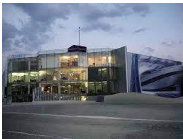
FIG.1-Cantiere Ferretti di Marotta Mondolfo
