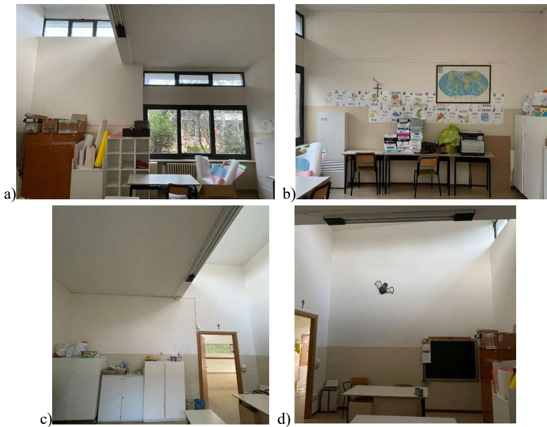
Figura 3.71 – Foto parete 1 (a), parete 2 (b), parete 3 (c), parete 4 (d) Aula Sostegno
