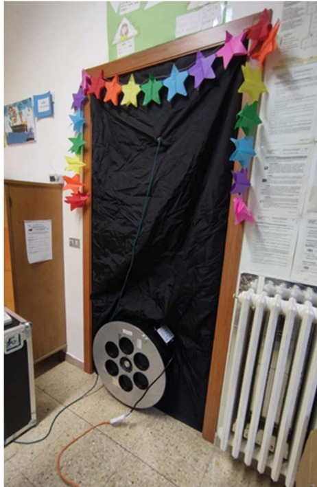
Figura 3.75 - Installazione del sistema per il blower door test
