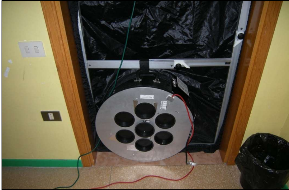
Figura 3.19 - Installazione del sistema per il blower door test
