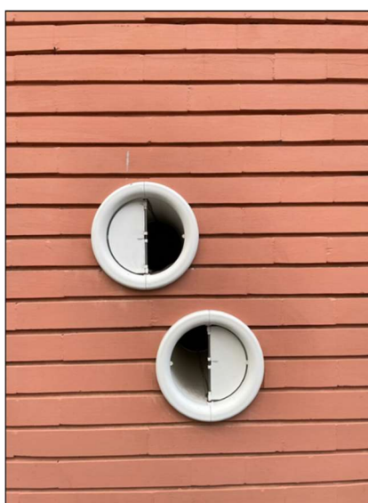
Figura 3.74 - Posizione della presa dell'aria esterna (in alto) e della presa dell'aria estratta (in basso) dell'unità VMC
