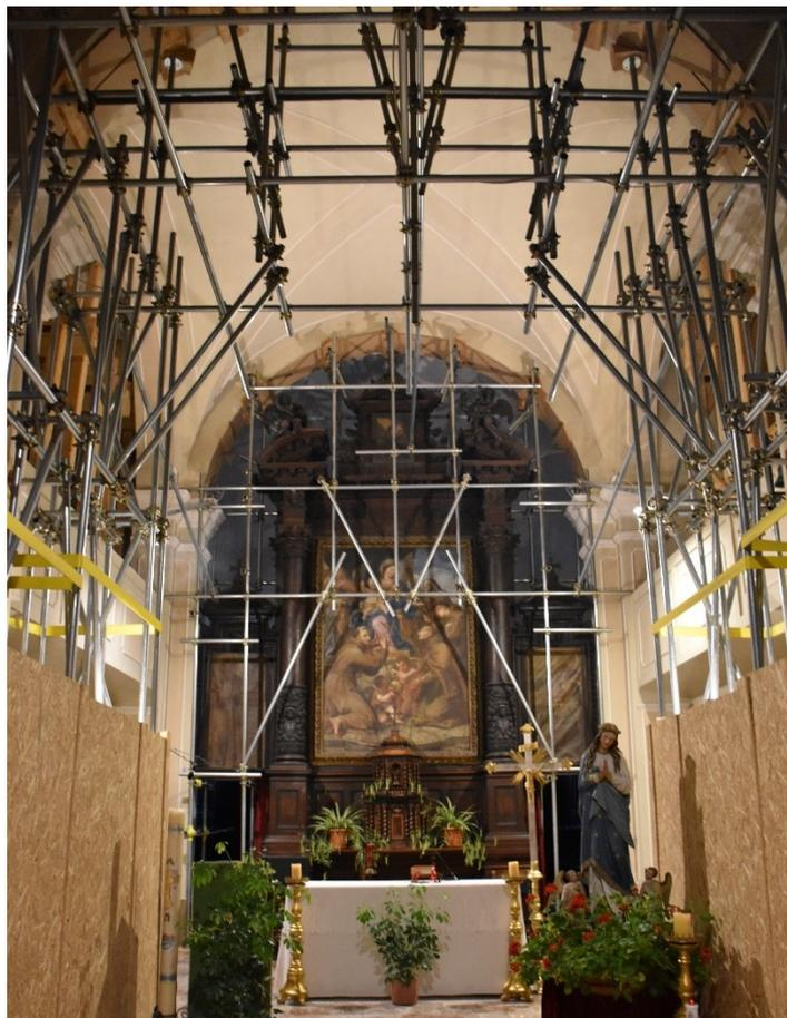
Figura 3.7 – Struttura di contenimento all'interno della chiesa
