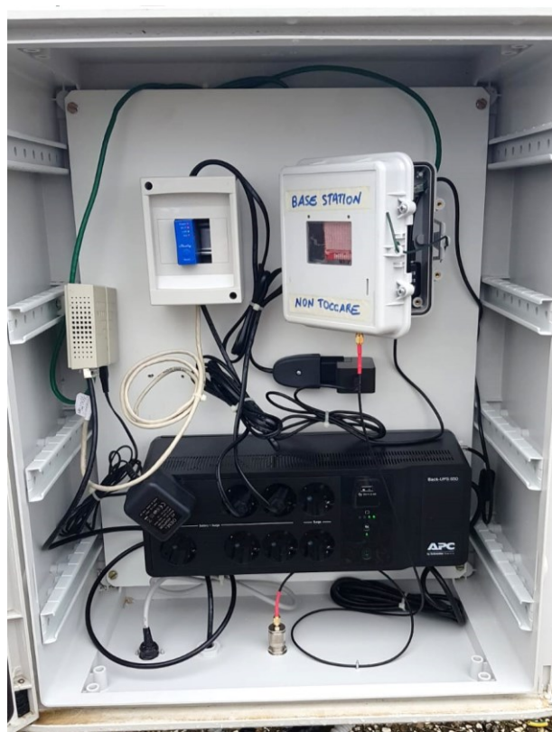
Fig.2 - Vista dell'interno della stazione base GPS-RTK (a) e della relativa antenna esterna (b)
