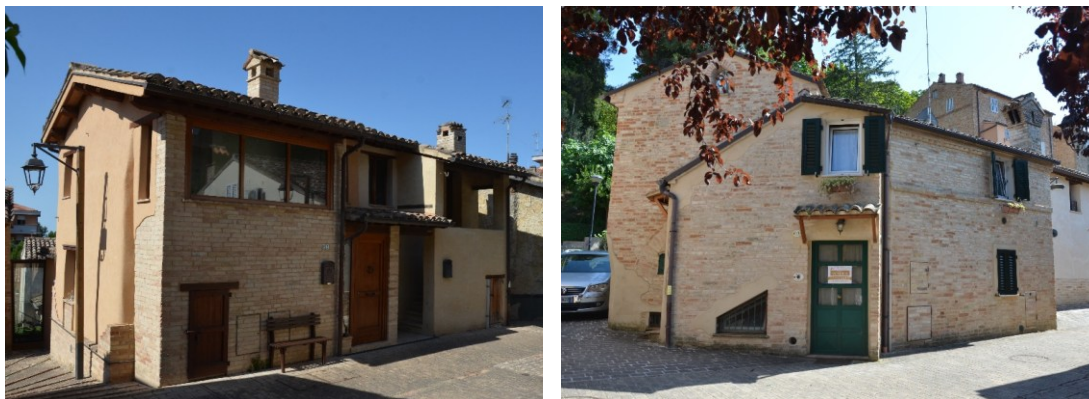
Figura 24 - due edifici ristrutturati nel rispetto delle Linee Guida imposte dal Vincolo
