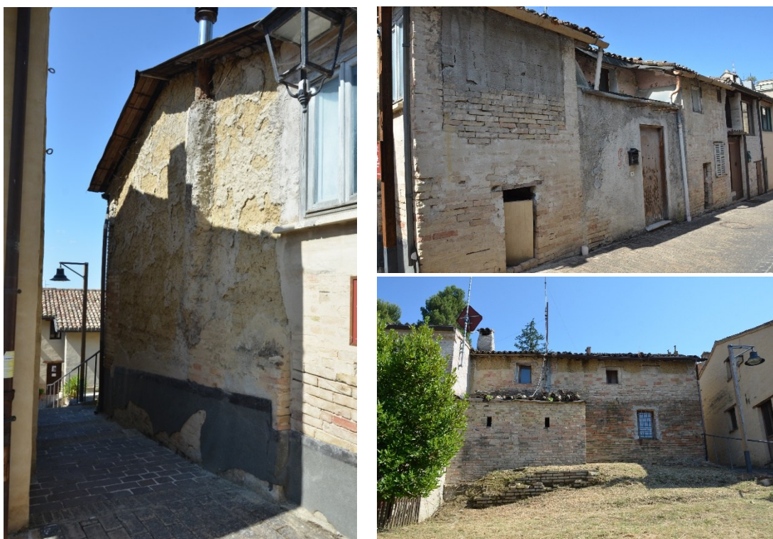
Figura 25 - unità non ancora restaurate sulle quali si notano i punti critici delle strutture (tetto, resistenza all'acqua) e gli interventi di manutenzione e di modifica avvenuti nel tempo
