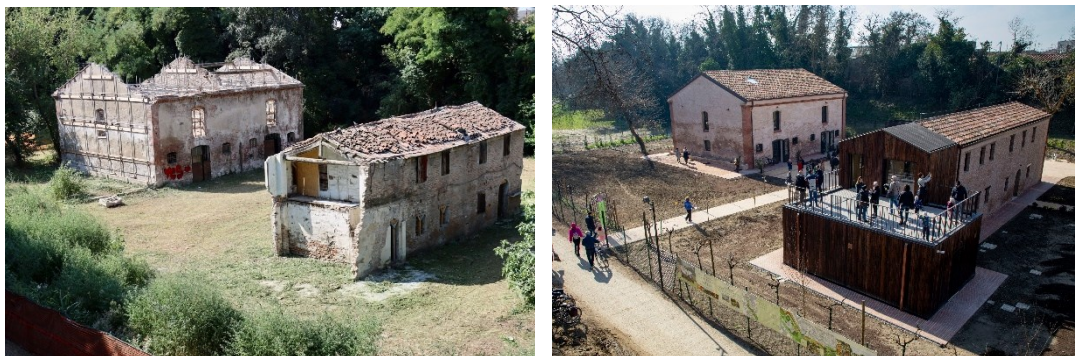
Figura 29 - prima e dopo gli interventi di recupero finanziati dal Comune di Ferrara sulla Casa dell'Ortolano, adottando il protocollo Historic Building (fonte: CronacaComune Ferrara)
