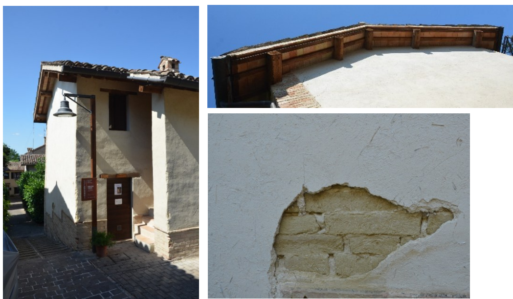
Figura 23 - esempio di recupero conservativo sul fabbricato dell'Ecomuseo dettagli sul ripristino della zoccolatura, degli elementi del tetto; focus sui mattoni crudi e sull'intonacatura esterna
