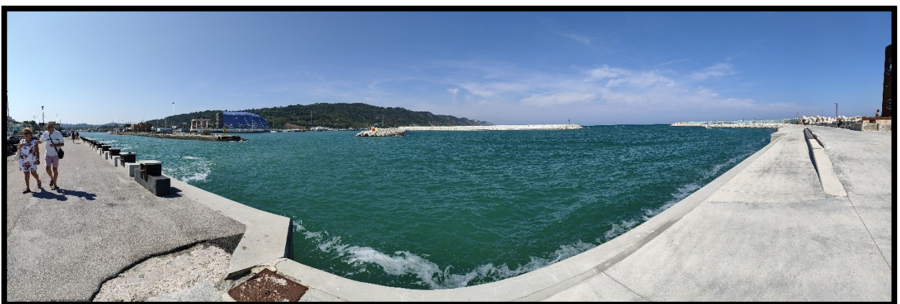
Fig. 4.58 – Immagine panoramica dell'ingresso portuale (7 settembre 2021)
