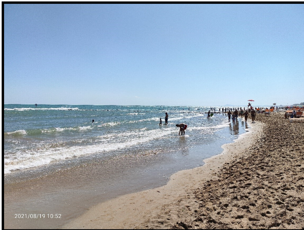
Fig. 4.123 – Scogliere sommerse della spiaggia di Torrette. Vista sud. (19 agosto 2021)
