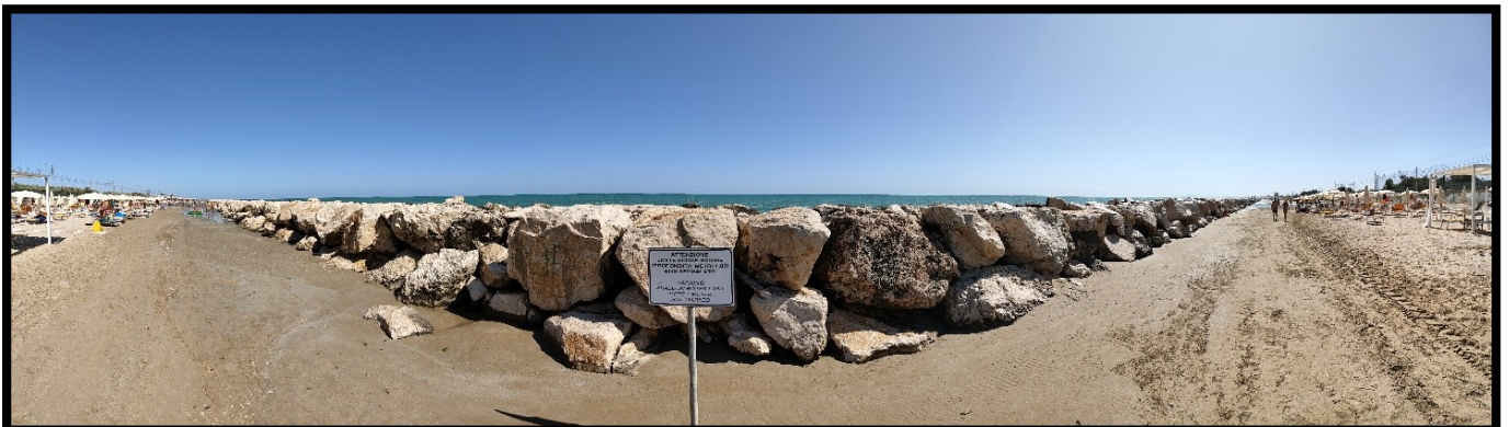
Fig. 4.121 – Scogliere radenti della spiaggia tra la foce del fiume Metauro e Torrette (19 agosto 2021)
