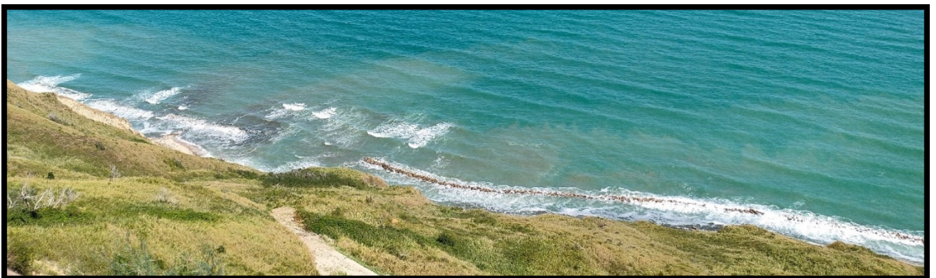
Fig. 4.21 – Scogliere emerse a protezione della spiaggia di Casteldimezzo (18 agosto 2021)
