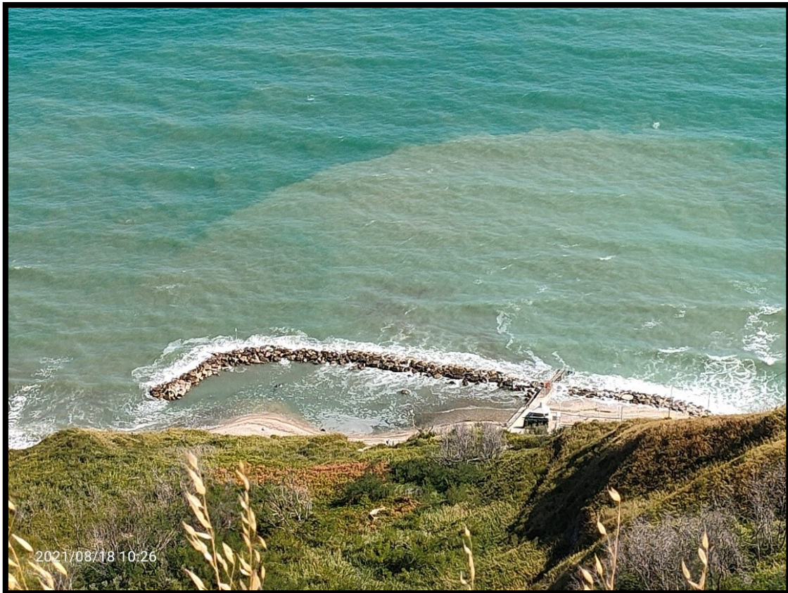
Fig. 2.2 - Dettaglio della scogliera vicino la spiaggia di Casteldimezzo (18 agosto 2021)
