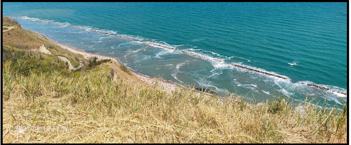
Fig. 4.22 – Scogliere emerse a protezione della spiaggia di Focara (18 agosto 2021)
