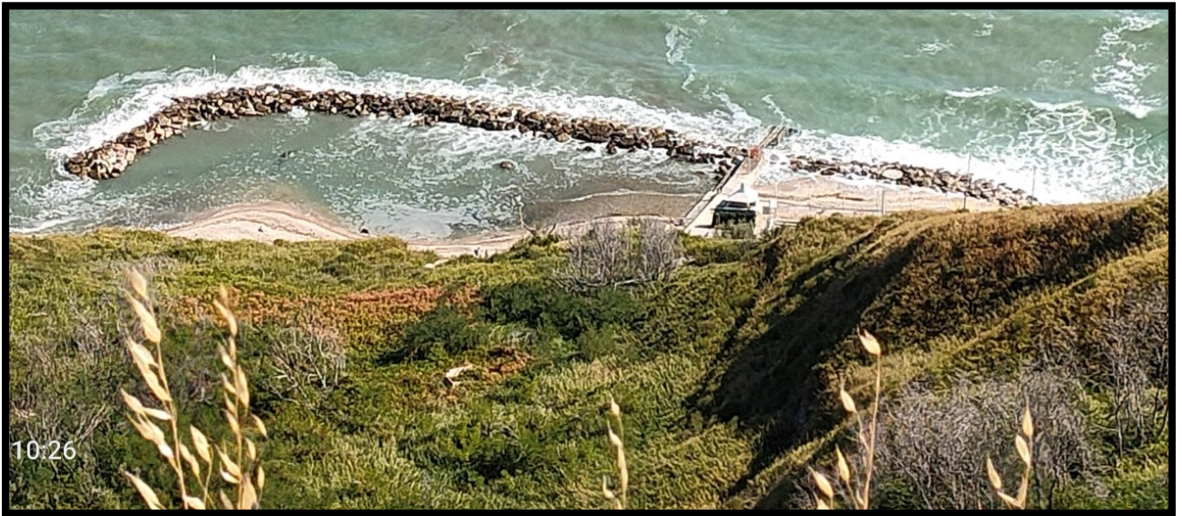
Fig. 4.20 – Dettaglio delle scogliere emerse sul lato sinistro della spiaggia di Casteldimezzo (18 agosto 2021)
