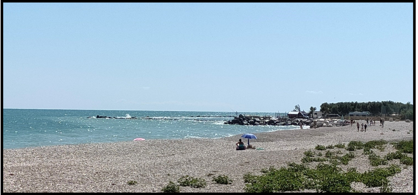
Fig. 4.120 – Opere marittime del litorale a sud della spiaggia di Sassonia, oltre la foce del fiume Metauro (19 agosto 2021)
