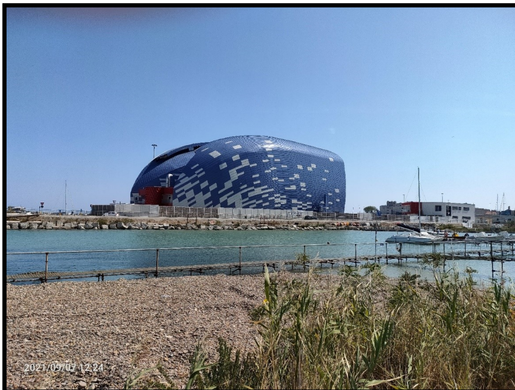
Fig. 4.62 – Capannone del cantiere Rossini (di recente costruzione, fine edificazione intorno luglio 2020) (7 settembre 2021)
