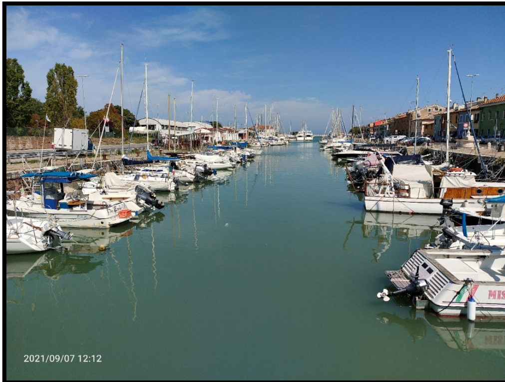
Fig. 4.61 – Canale terminale del porto pesarese, vista dal basso del ponte della strada Panoramica Adriatica (7 settembre 2021)
