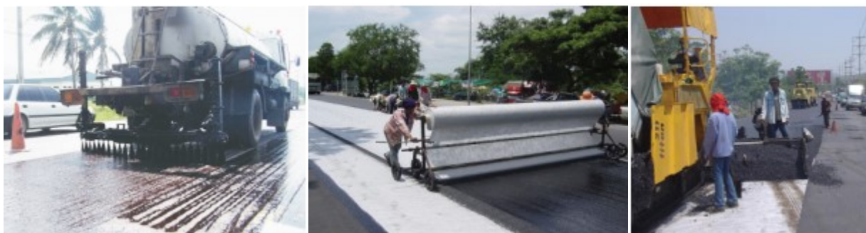
Figura 2.4.1-6 Fasi di applicazione del geotessuto
