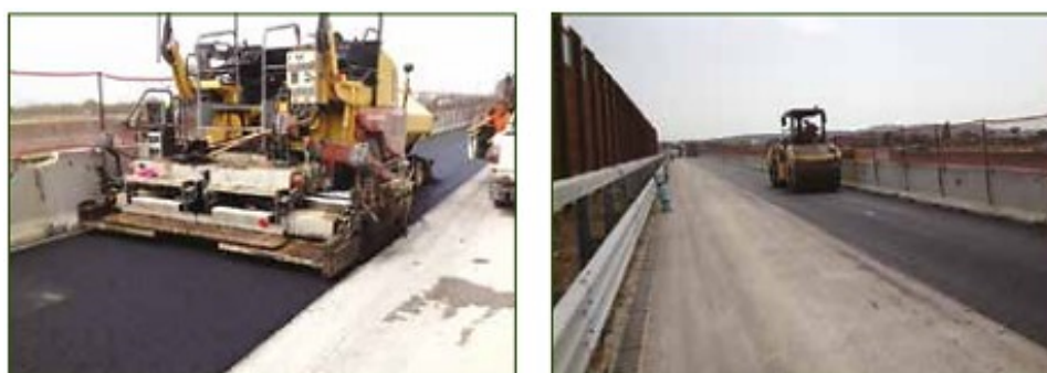
Figura 2.4.3-6 Realizzazione strato in conglomerato bituminoso
