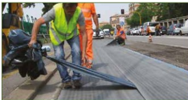
Figura 2.4.3-4 Rimozione del film siliconato
