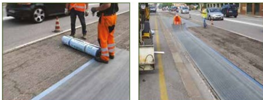
Figura 2.4.3-1 Stesa geosintetico
