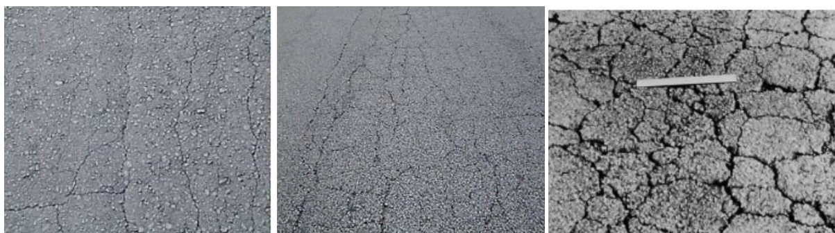
Figura 2.2.2-2 Diverse severità di fessurazioni da fatica
