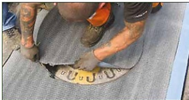
Figura 2.4.3-3 Taglio del geocomposito
