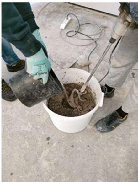
**Fig.4.1** – miscelazione delle componenti con agitatore meccanico.
