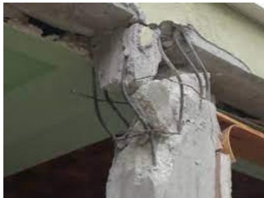
Figura 1.17b – Perdita di plasticità delle barre di armatura
