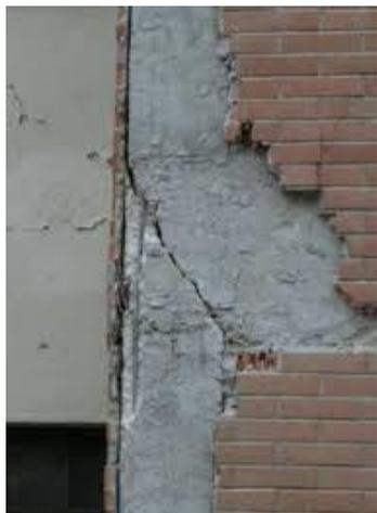
Figura 1.17a – Fessurazione del nodo a seguito dell'azione sismica
