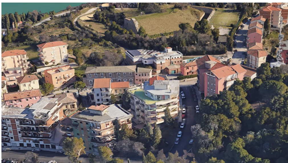
Figura 3.1 Edificio caso studio, estratto daGoogle Earth
