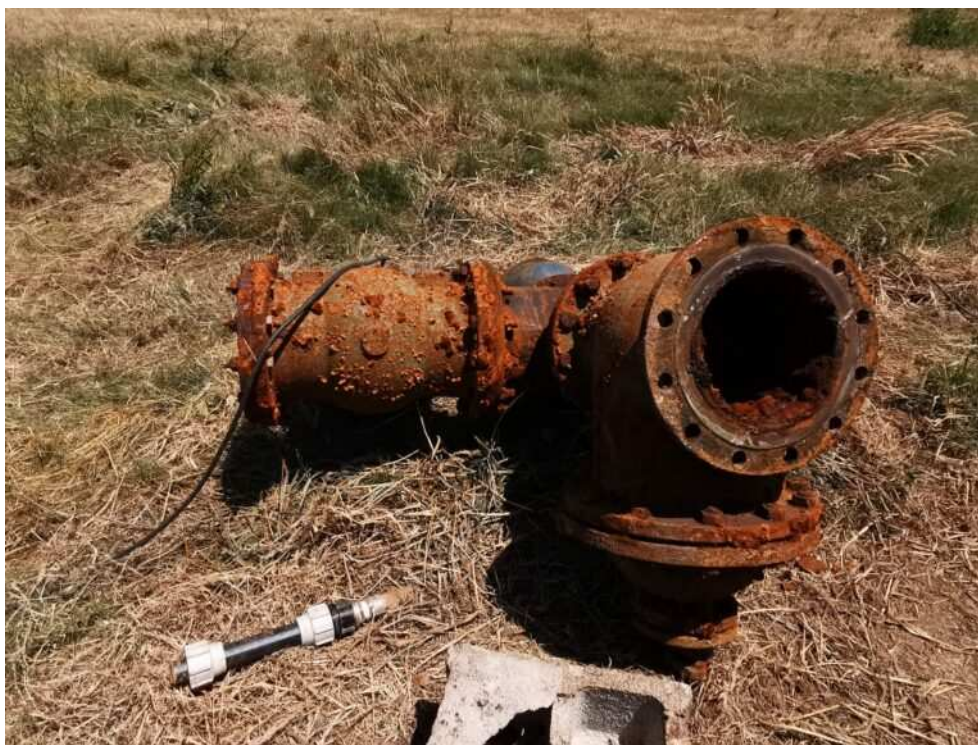
Fig. 1.2.1.1 – Esempio delle tubature, obsolete e arrugginite che portavano l'acqua ad Olbia 29 .
