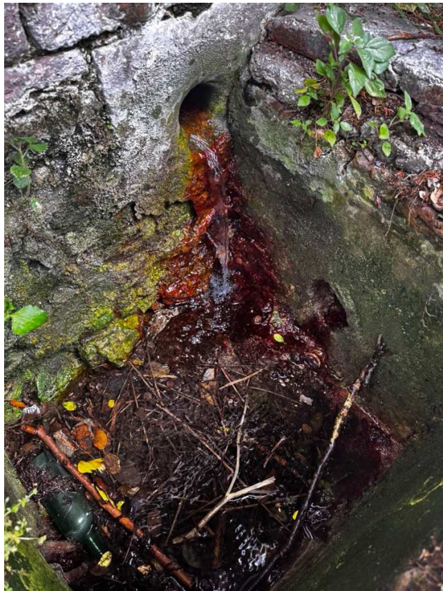
Fig. 3.1.1.1 – Punto di uscita chiusino secondario. Si vede bene che la direzione della mandata è in direzione trasversale rispetto al punto di uscita della vasca alimentata dalla sorgente, questo può indicare che la condotta potrebbe essere allacciata a una rete idrica urbana.
