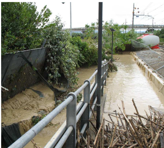
Figura 35: S.S.16 - effetti dell'allagamento sulla ferrovia
