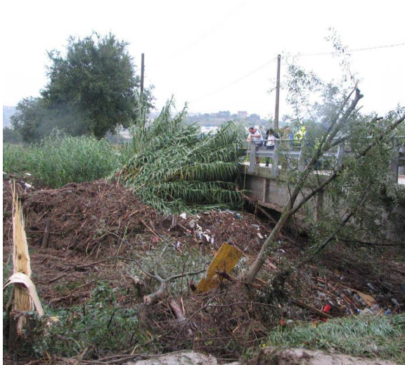
Figura 31: Ponte sull'Aspio - accumulo di materiale trasportato nel corso della piena
