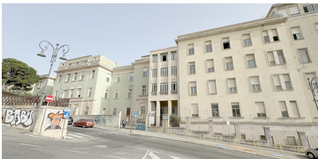
Figura 5.20: La foto relativa alla situazione reale del cantiere dell'edificio A
