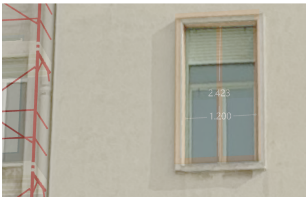
Figura 5.24: Misurazioni con la sovrapposizione delle immagini
