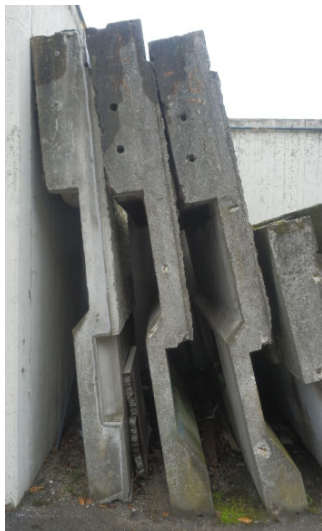
a) Pannelli prefabbricati di tamponatura
