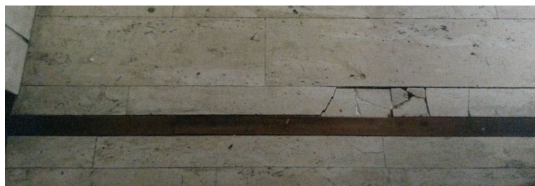
Figura 2.4-Giunto tra corpo scala e torre
