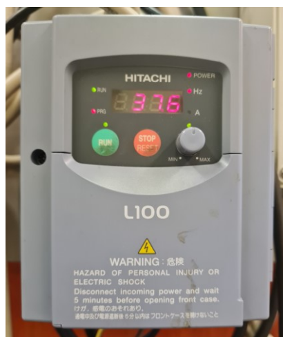
Figura 4.7 - Inverter per regolare la velocità di rotazione
